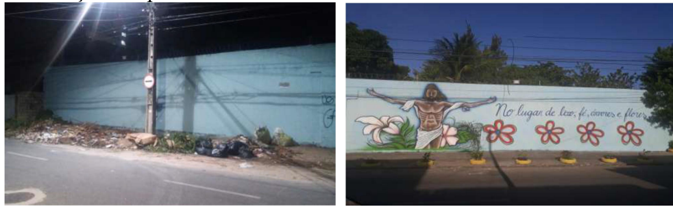
Figura 16 – Requalificação de espaços públicos antes e depois na erradicação de “pontos de lixo”
