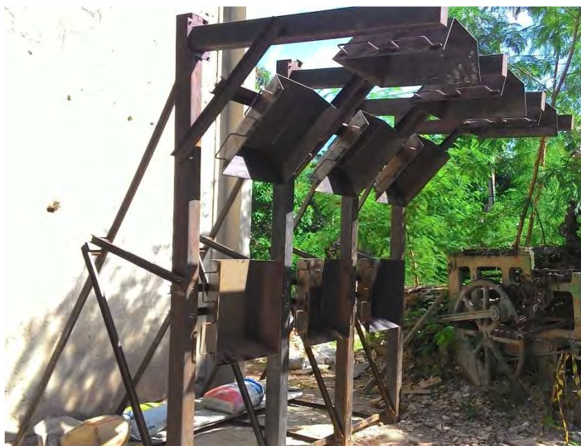
F – Estrutura montada
