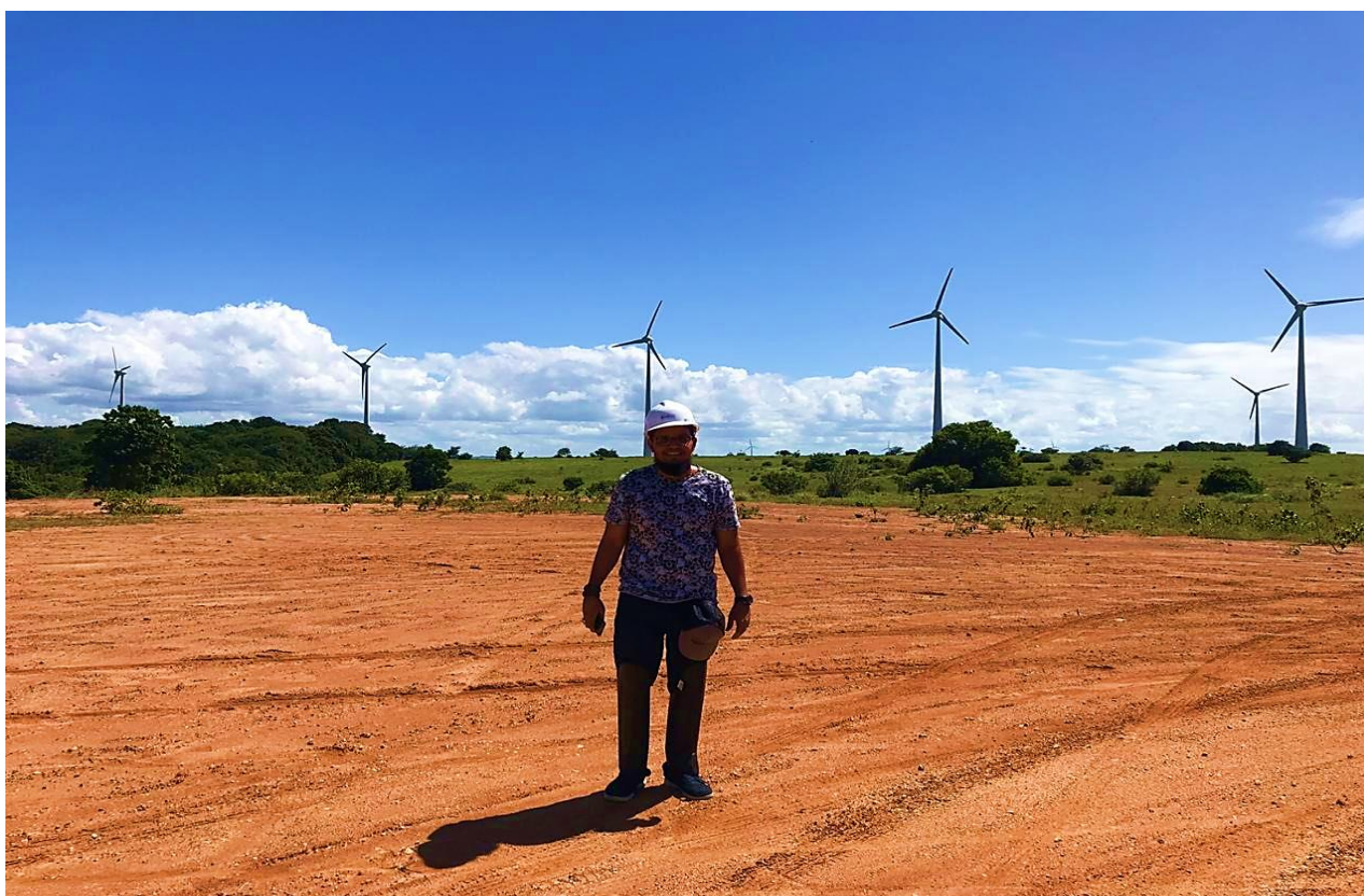
Figura 22 – Visita ao Parque E lico Vale dos Ventos
