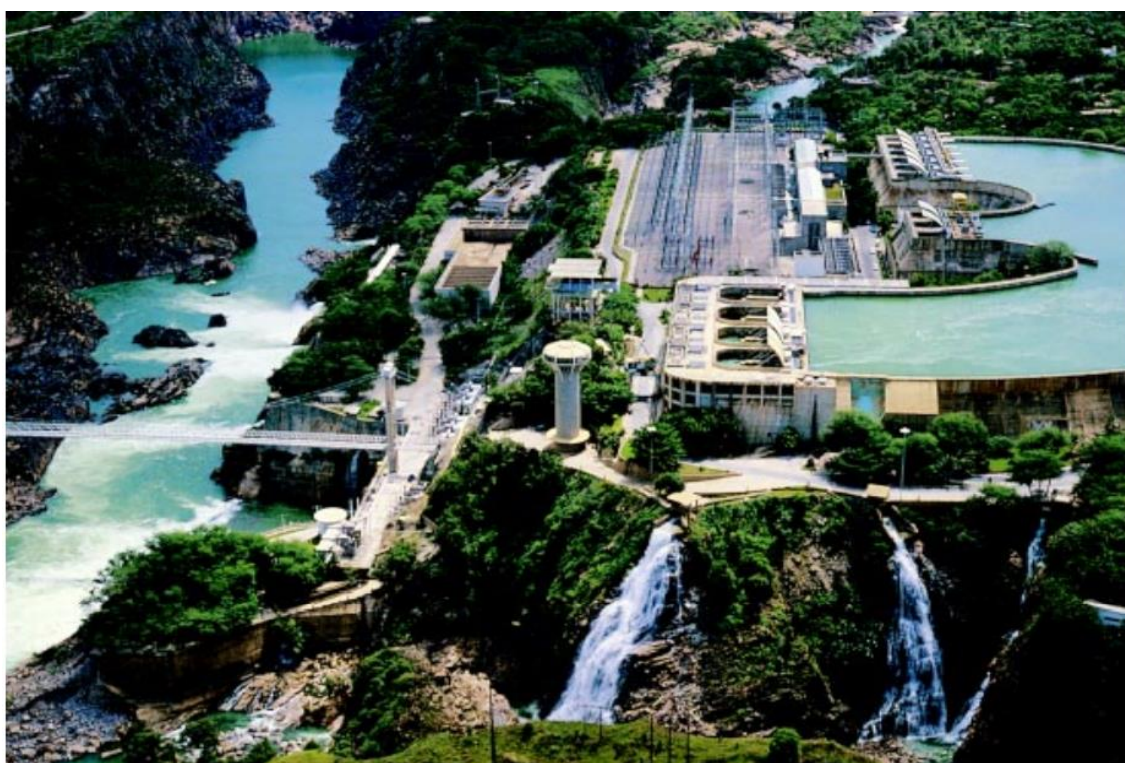
Figura 6 – Vista aérea do Complexo Hidroelétrico de Paulo Afonso
