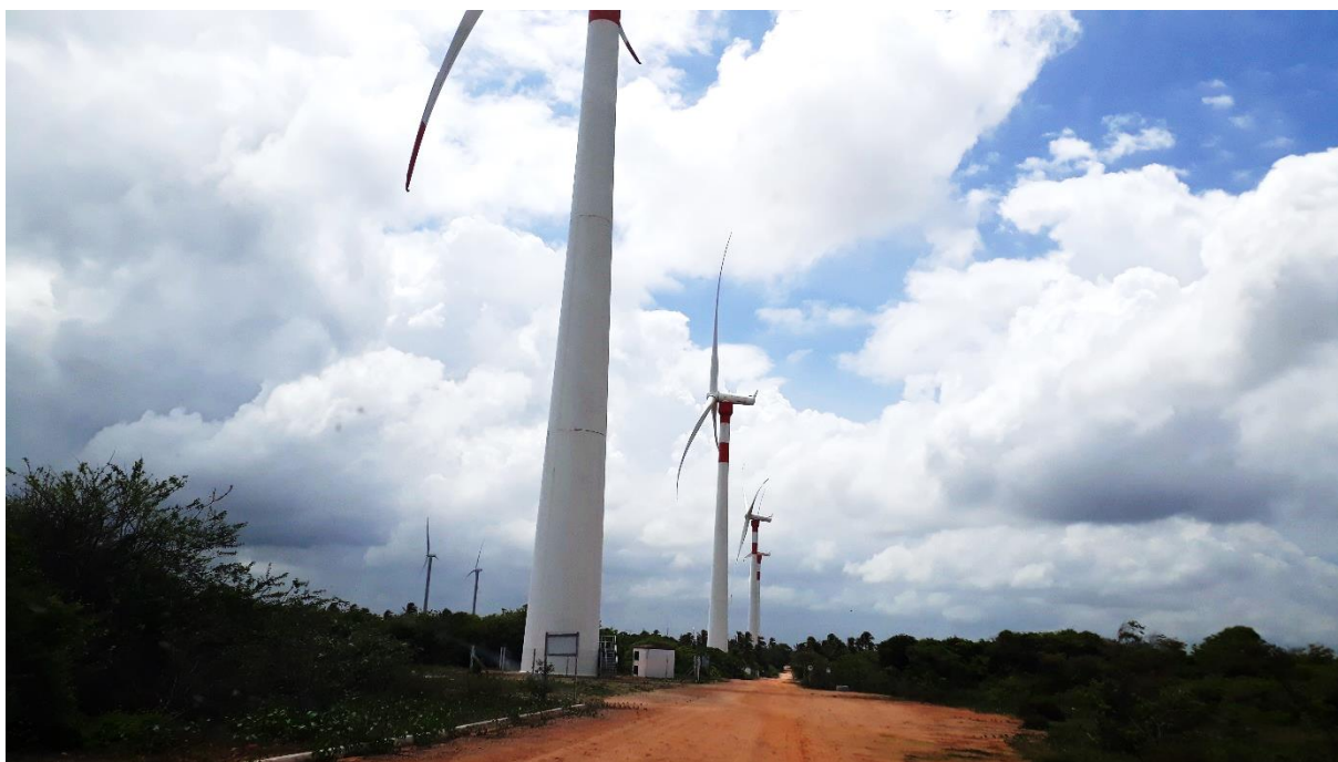
Figura 18 - Instalações internas do parque eólico de Trairi – Ce
