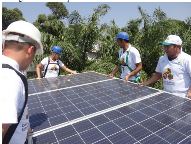
Figura 2 - Instalação dos módulos FV no teto do LEA
