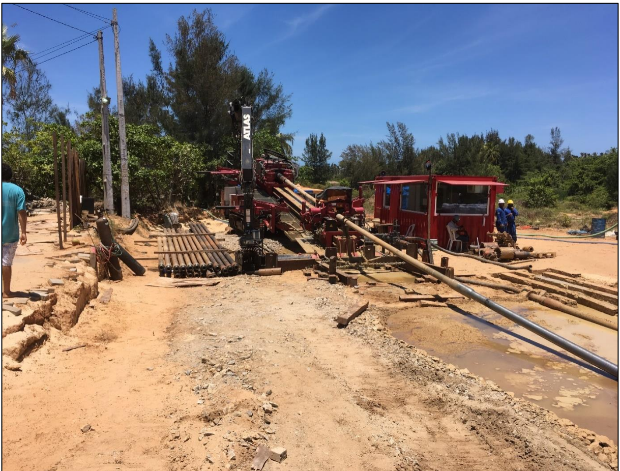
Imagem 2 – Cavação de poços às margens do Lagamar do Cauípe
