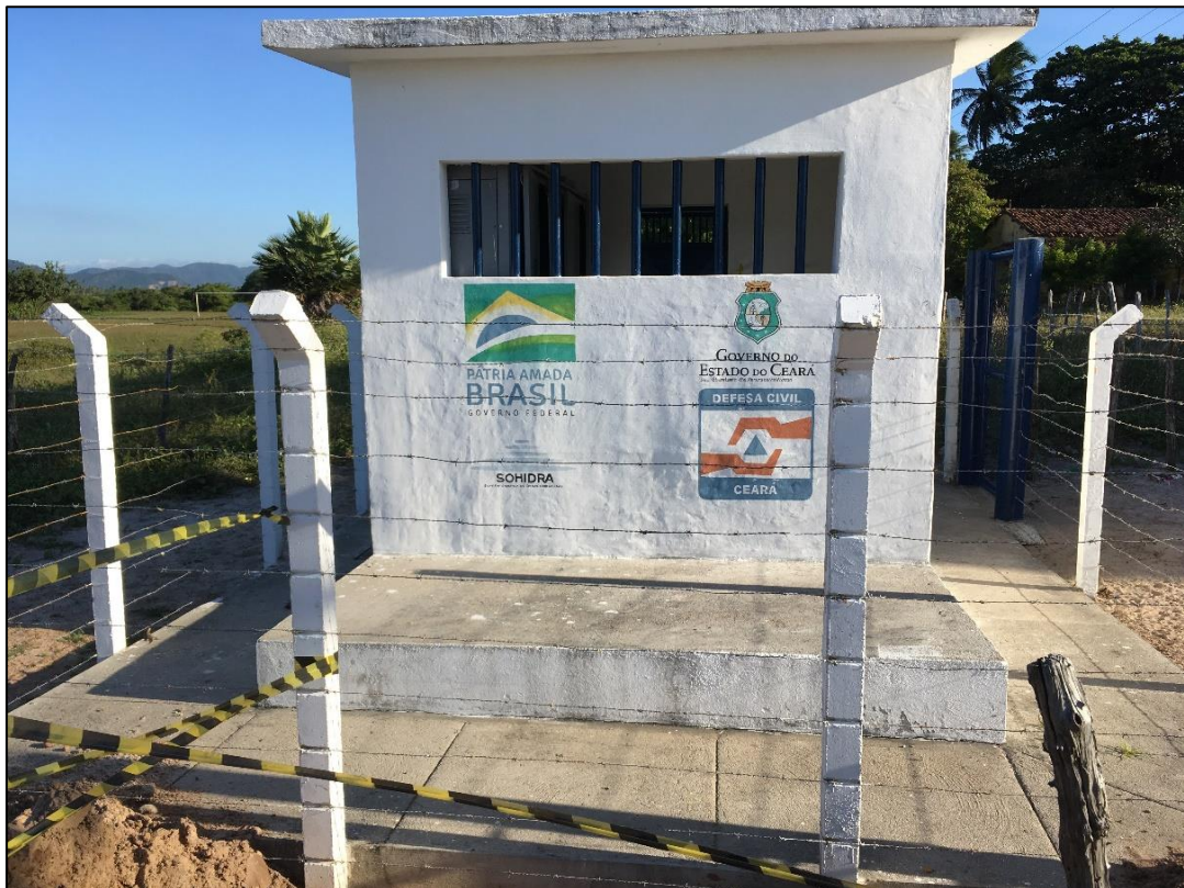
Imagem 1 – Casa da bomba que retira água do Lagamar do Cauípe
