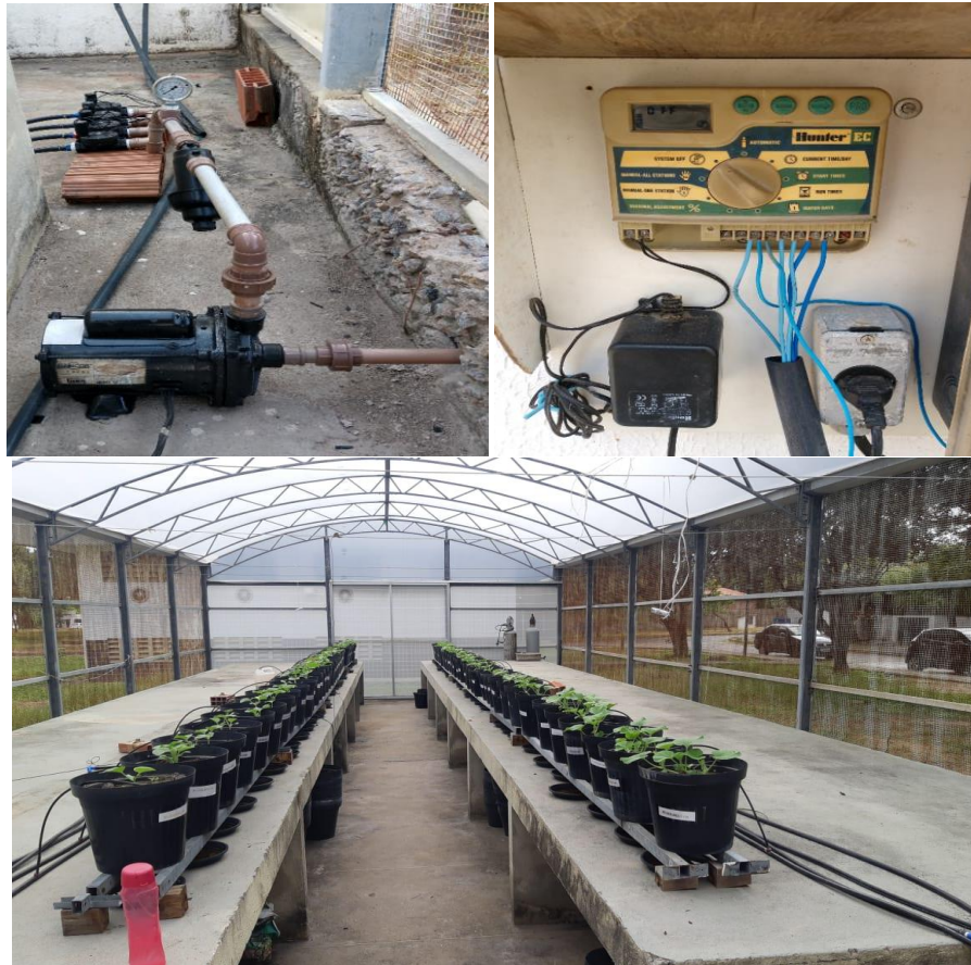
Figura 4 – Vista do cabeçal de controle, controlador de irrigação e sistema de irrigação instalado. Embrapa Agroindústria Tropical, Fortaleza, Ceará, 2019
