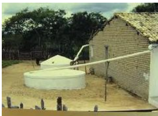
Figura 13- Cisterna de Placas
