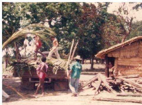
Figura 8- Reconstrução das casas em Sítio Novo - Santa Rita
