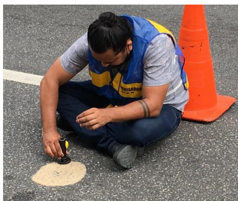
Figura 34 — Espalhamento da areia padronizada na superfície do pavimento
