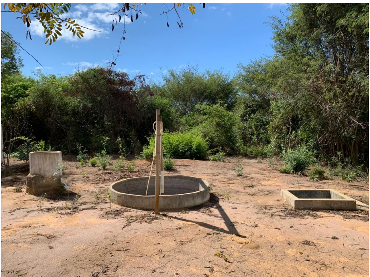
Figura 14 - O biodigestor de lixo
