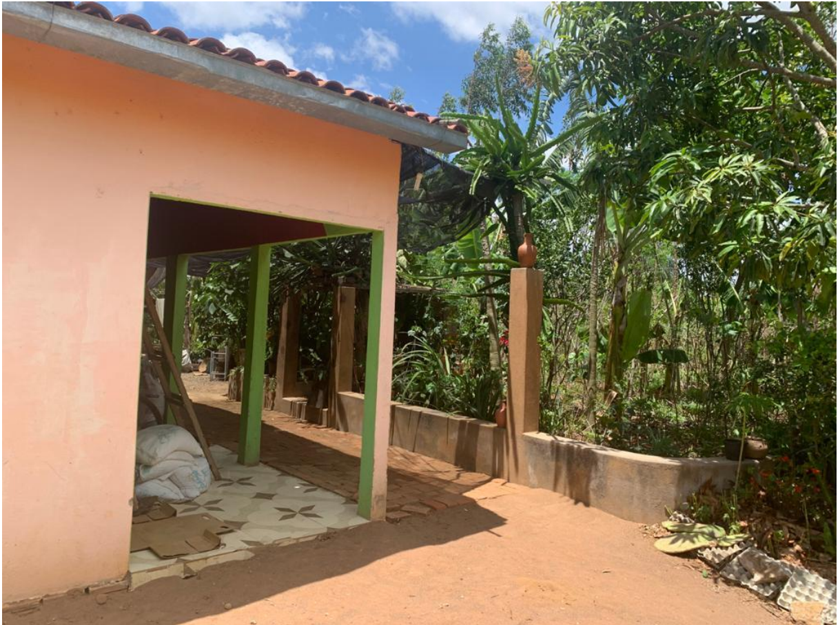
Figura 17 - Vista do muro da parte anterior da casa
