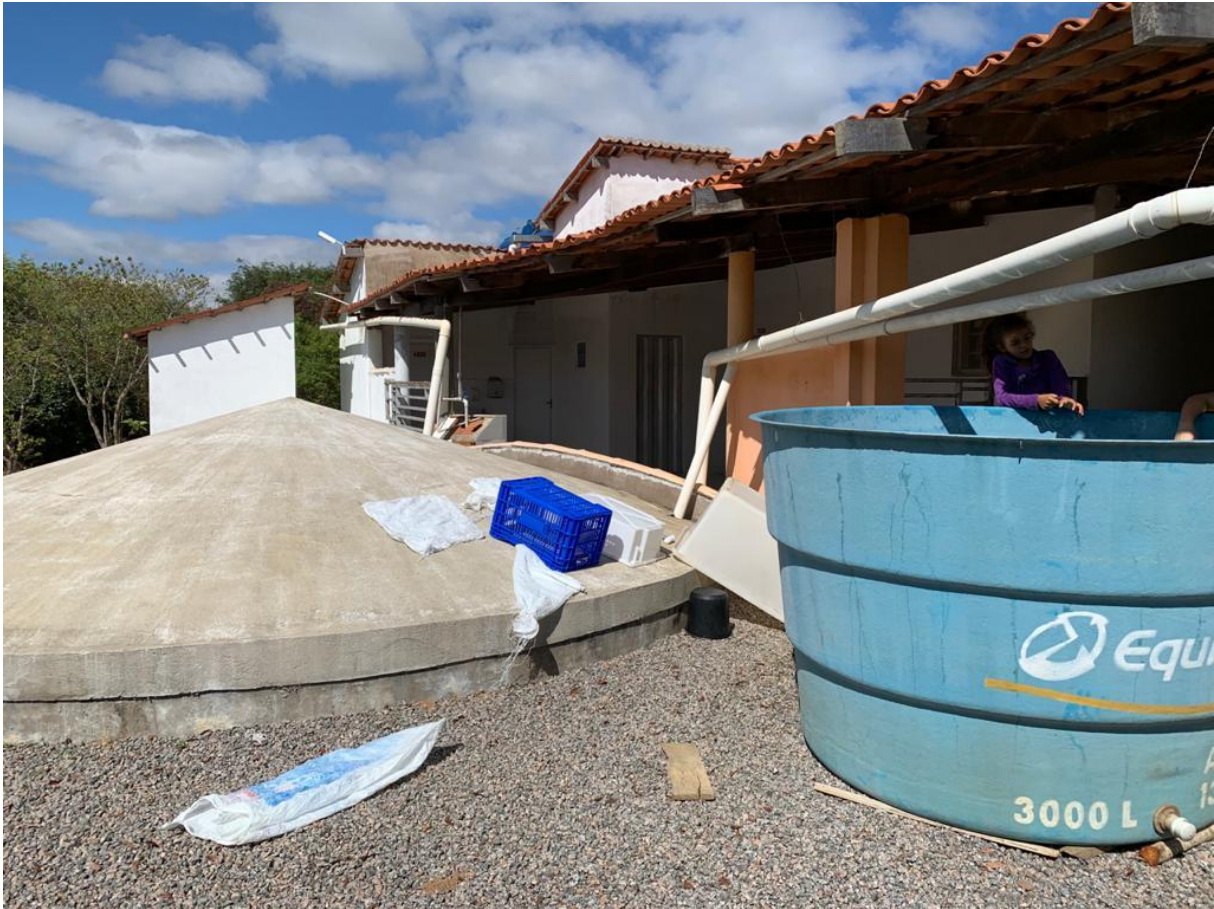
Figura 10 - Reservatório de água
