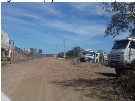
Figura 28 – Equipamentos da construção
