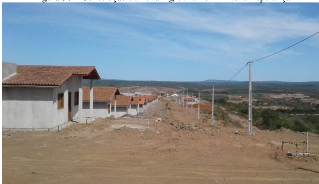
Figura 30 – Construção da nova Agrovila no PA Nova Esperança
