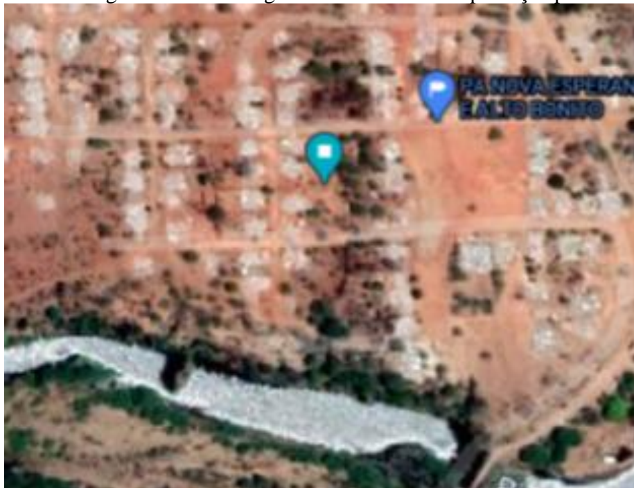
Figura 25 – Imagem vertical da Agrovila do PA Nova Esperança após demolição
