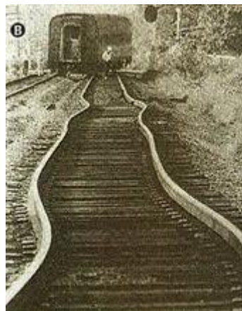
Figura 19 – Trilhos distorcidos devido a dilatação térmica
