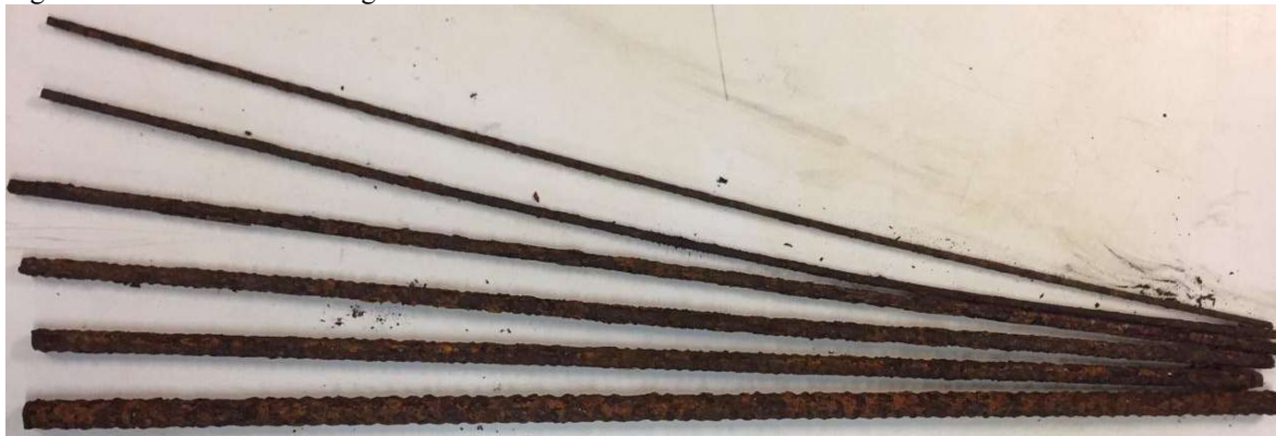
Figura 22 – Diâmetros dos vergalhões corroídos
