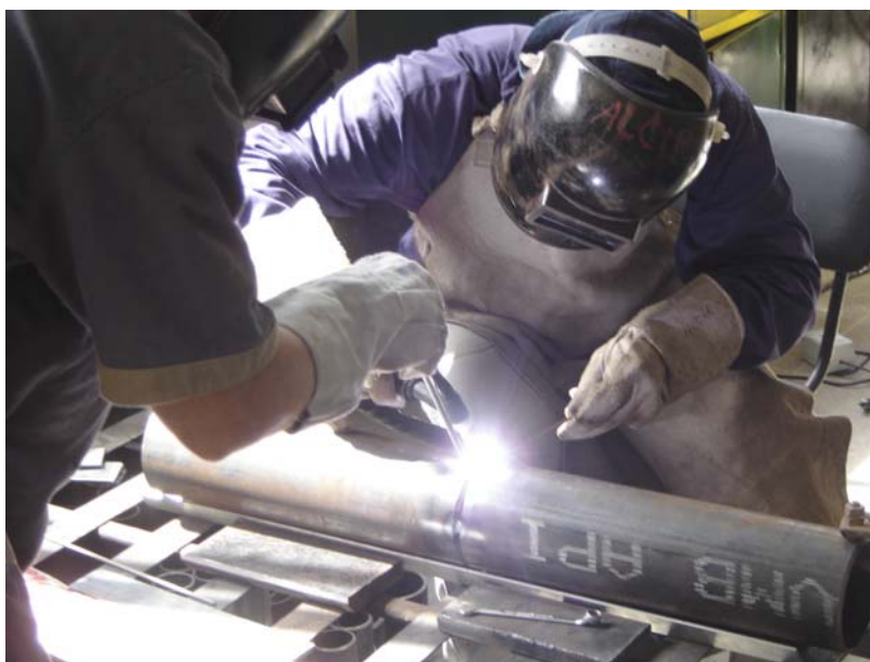
Figura 28. Ponteamento dos tubos para a soldagem.
