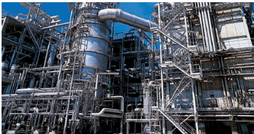
Figura 1. Unidade de refino de petróleo.
