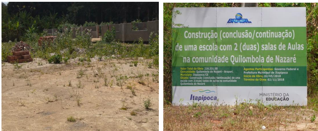
Figura 226 e 227 – O terreno e a escola em construção.
