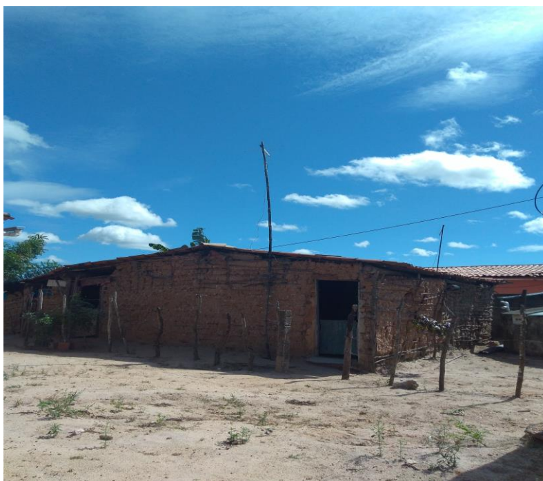
Figura 80 – Casa de taipa.
