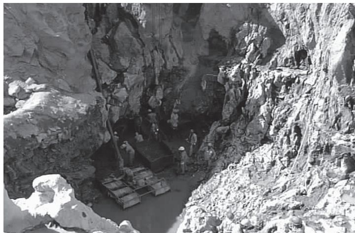
Fig. 2 – Serviço de bombeamento dentro do "Páleo Jr.", fonte: DNOCS (2004).
