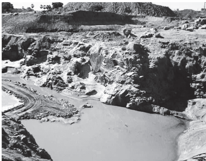
Fig. 1 – Situação ao final do período dos serviços de reescavação, executados na região do “Páleo Canal”, entre as estacas 112+0,00 e 116+0,00, fonte: DNOCS (2004).
