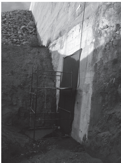
Fig. 18 – Escavação e recuperação do trecho enterrado da fissura e aplicação da manta, fonte: arquivo pessoal da autora.
