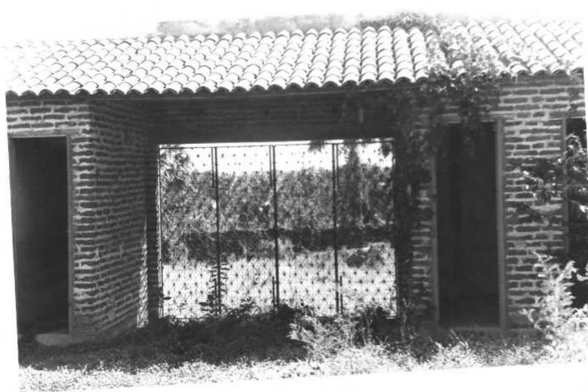
Figura 32 – Construção do Centro Educacional Nossa Senhora das Brotas. Vista frontal. Fonte: Acervo fotográfico de Alcides Monteiro Chaves.
