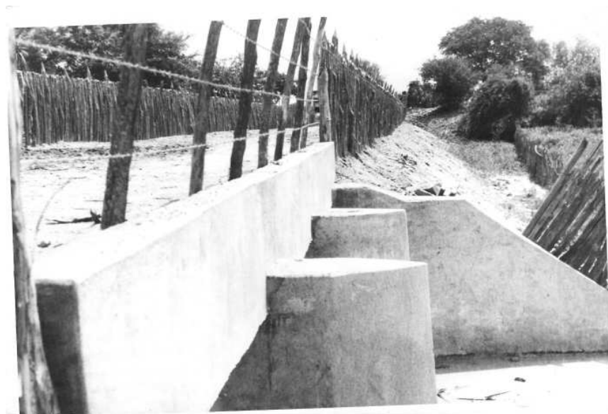
Figura 11 – Construção da barragem do Riacho de Zé Chaves. Construída no 1º mandato de Alcides Monteiro (1966-1970).
