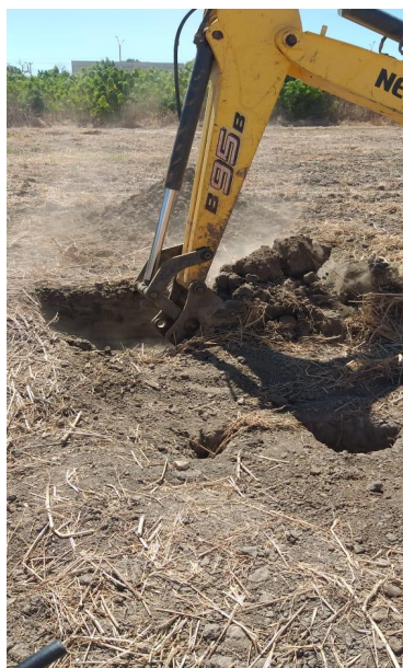
Figura 19 – Escavação da trincheira com a retroescavadeira.
