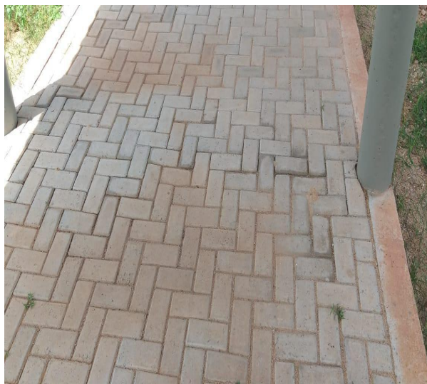
Figura 1 – Levantamento dos Blocos de concreto na Passarela do RU
