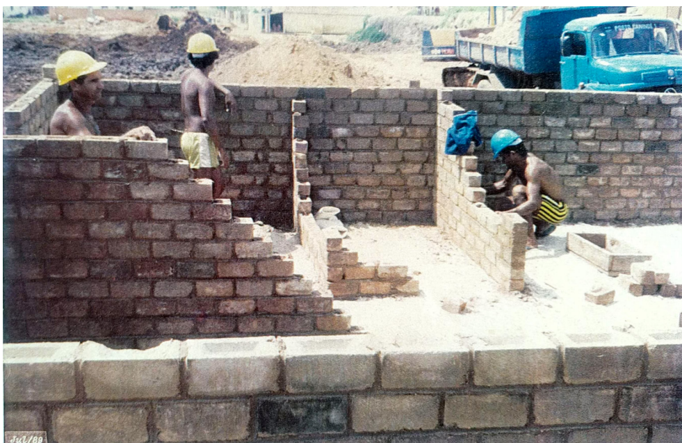
Figura 19 - Foto antiga de mutirants construindo casa com tijolos de solo-cimento. Fonte: Acervo de moradora.
