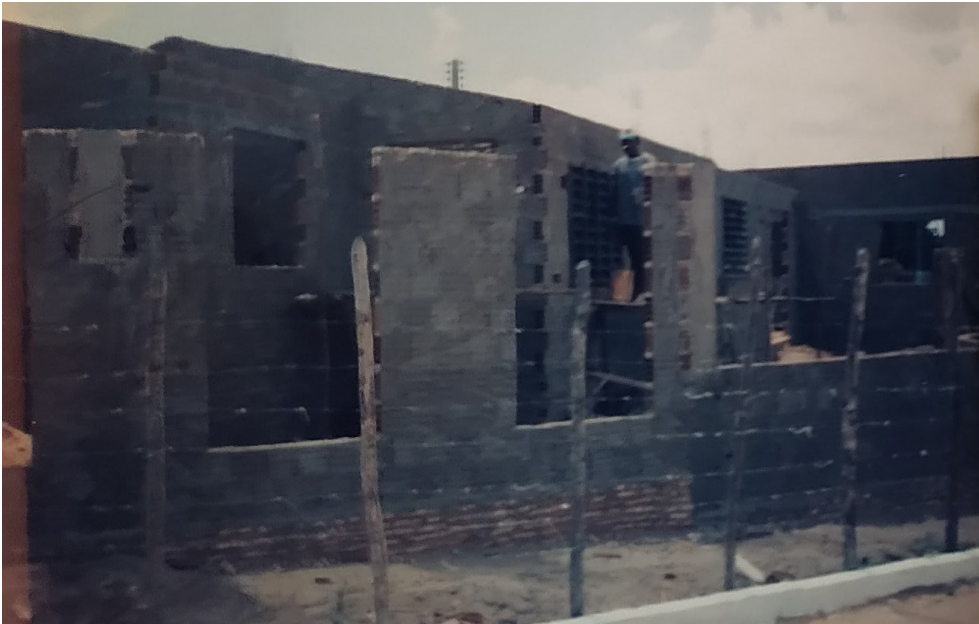
Figura 43 - Centro Comunitário da Associação Santa Edwiges em construção. Fonte: (CÁRITAS, 1997)
