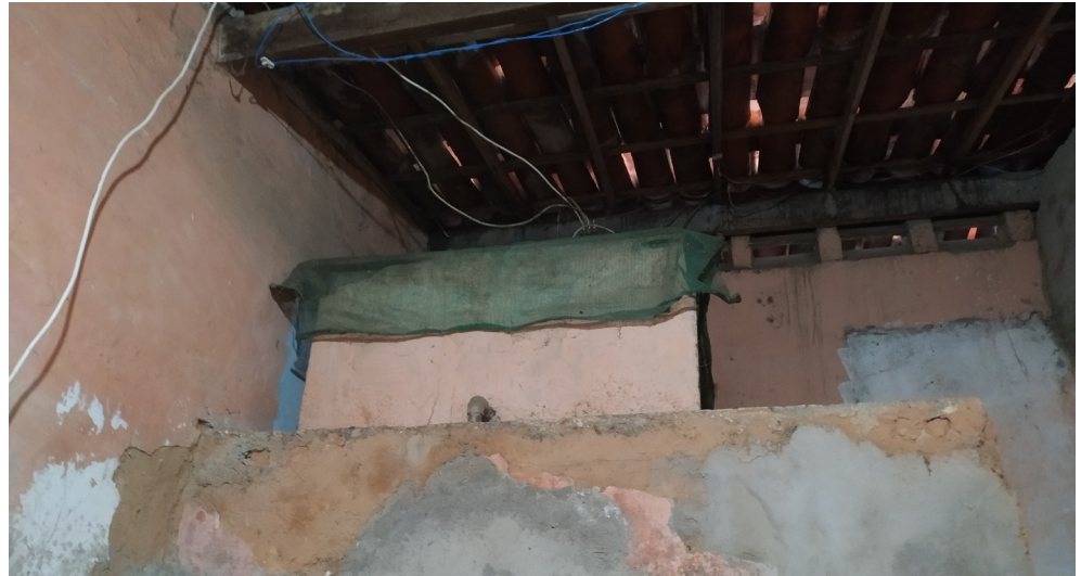
Figura 21 - Foto atual de parede de tijolos de solo-cimento original de uma das casas do mutirão 50. Dezembro/2014.
