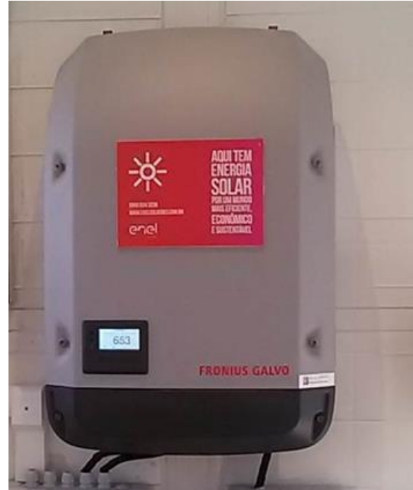
Figura 2 – Inversor fotovoltaico Fronius Galvo 2.0 do sistema fotovoltaico de potência 1,5kWp.
