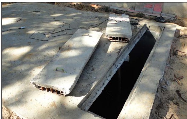
Figura 10. Tanque para termoacumulação.
