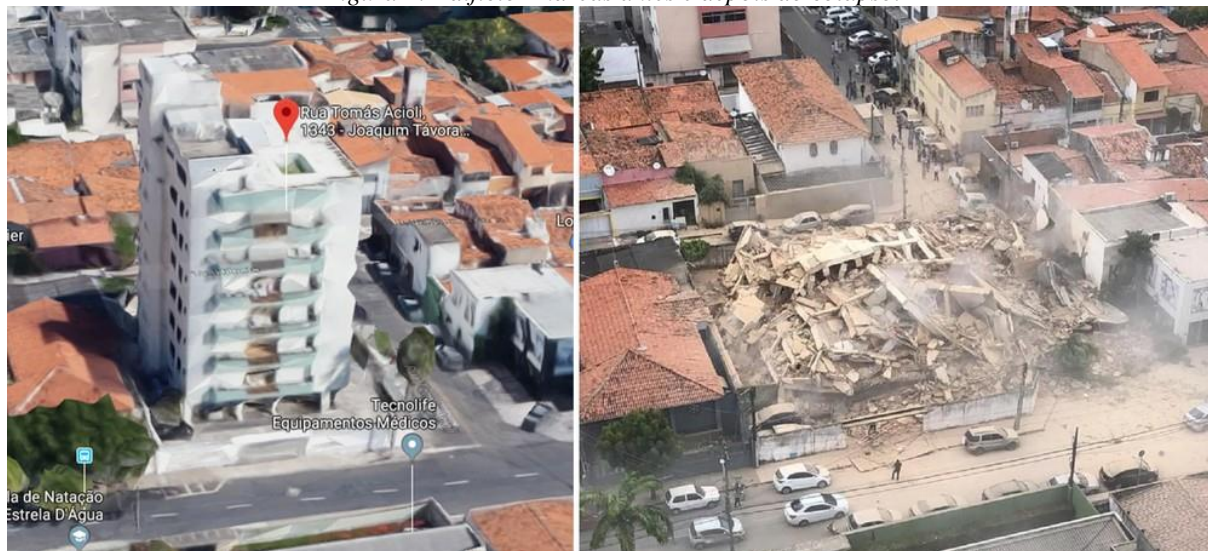
Figura 2: Edifício Andreas antes e depois do colapso.
