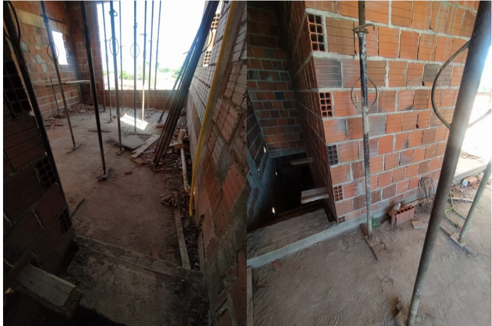
Figura 30 – Espaço onde serão feitas as vigas invertidas.
