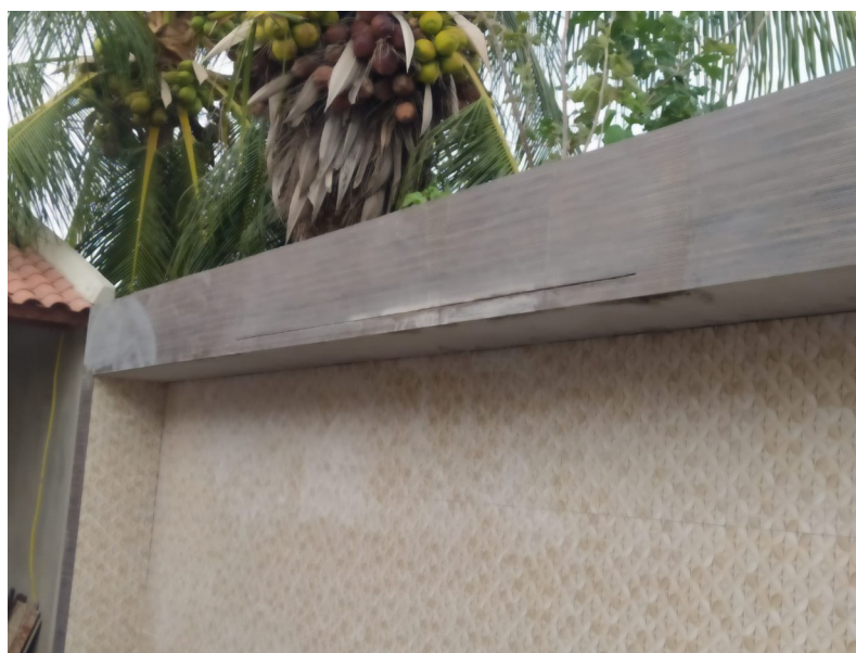
Figura 15 – Parede da cascata.
