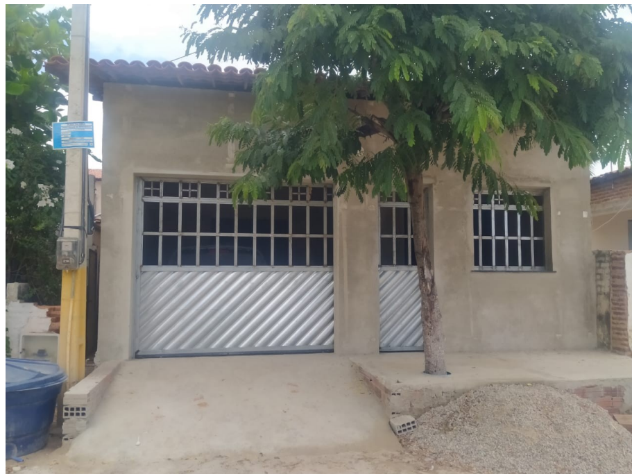
Figura 3 – Fachada da obra 1.
