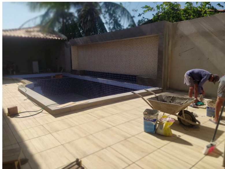
Figura 17 – Piscina quase concluída.
