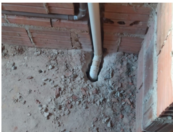
Figura 20 – Tubulação colocada após abertura de buraco na laje.
