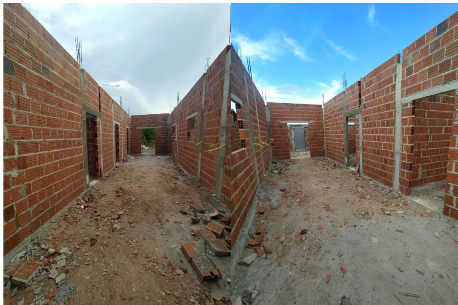
Figura 8 – Parte interna da obra.
