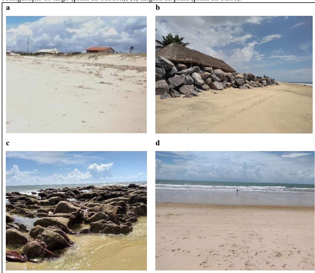
Figura 4 Exemplos de indicadores visuais utilizados para definir o grau dos impactos de erosão costeira. (a) Presença de dunas (praia da Taíba), (b) presença de obras de contenção (praia da Tabuba), (c) configuração ao largo (praia da Tabuba), (d) largura da praia (praia da Taíba).
