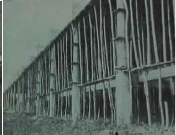
Fotografia 2 – Construção da Maternidade Popular de Fortaleza, s/d
