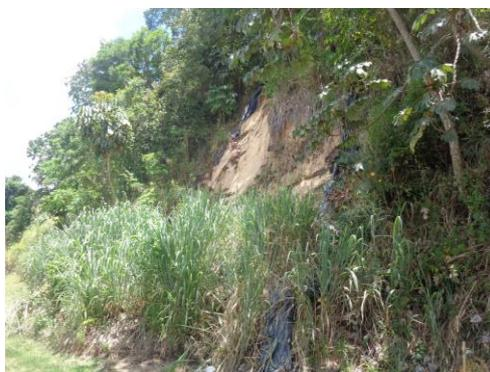
Figura 2. Cicatriz de rupturas recentes na parte inferior do talude.
