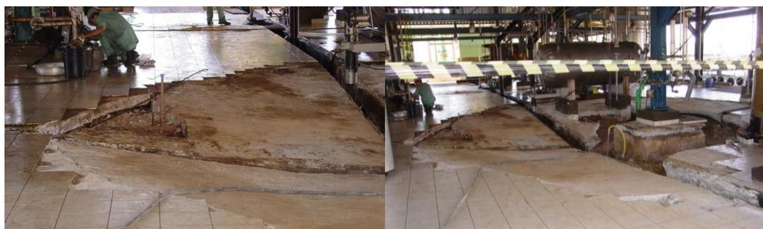
Figura 3. Afundamento do piso provocado pelo colapso do solo.
