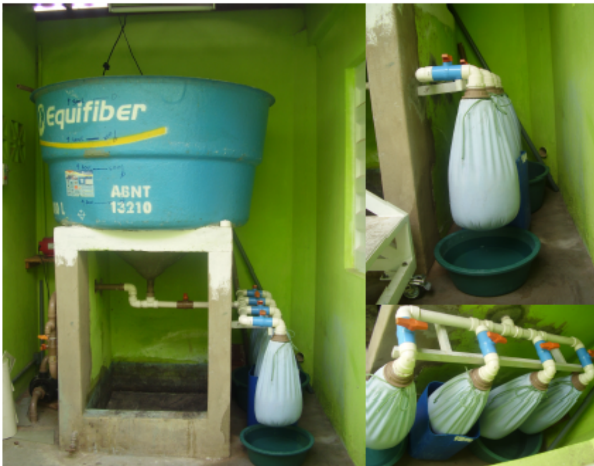
Figura 3 - Estação de Tratamento de Efluentes implantada em indústria de joias folheadas na cidade de Juazeiro do Norte.
