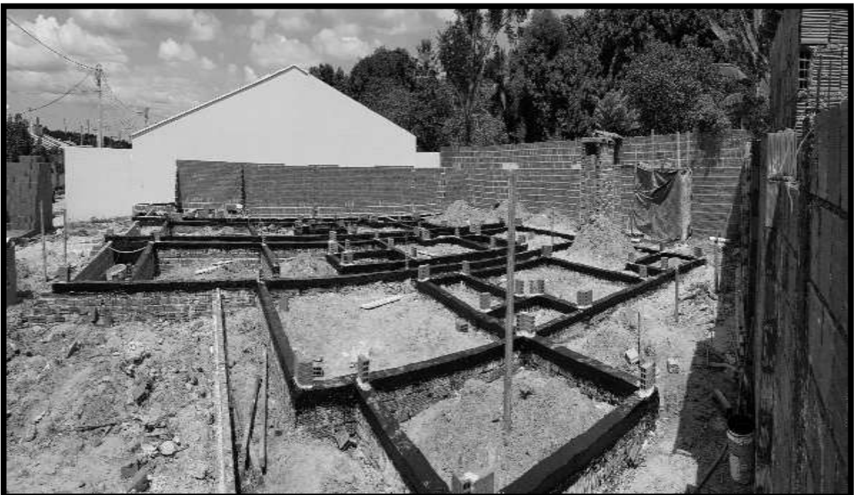
Figura 3 – Residencial Itaitinga. Impermeabilização das fundações 2
