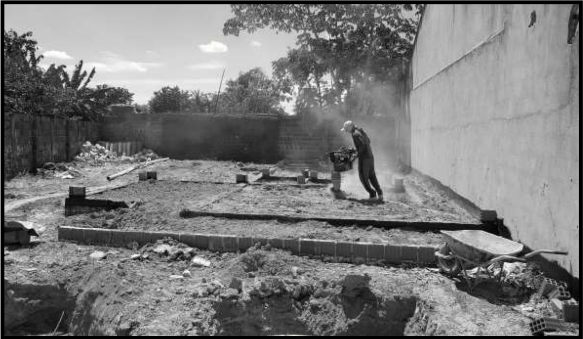
Figura 2 – Residencial Itaitinga. Compactação 1
