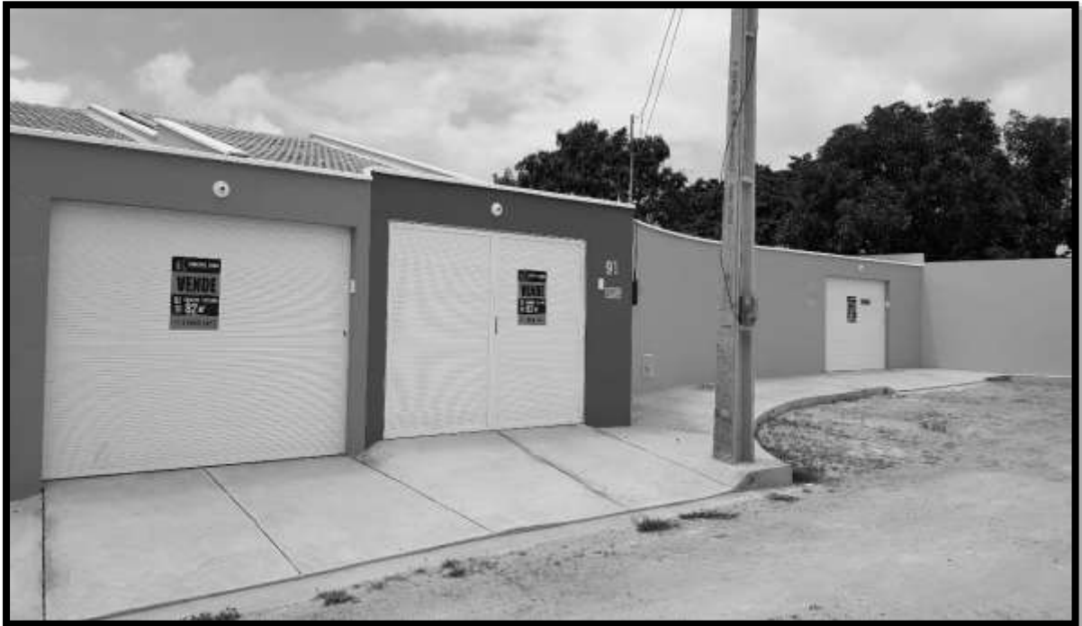
Figura 9 – Residencial Itaitinga. Casa acabada. Vista externa
