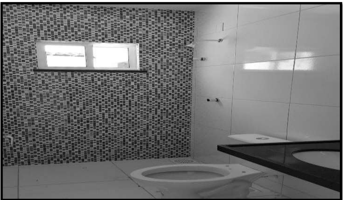
Figura 7 – Residencial Itaitinga. Casa acabada. Vista interior. Material utilizado. Banheiro
