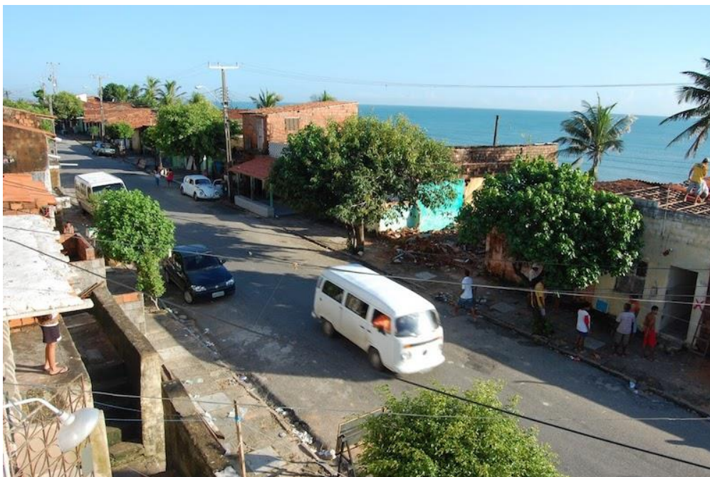
Figura 63: Avenida Santa Elisa, onde futuramente passaria a via litorânea do Vila do Mar. Todas as casas que se encontram de costas para o mar foram removidas com o projeto. Em diversos trechos da antiga avenida não era possível visualizar o mar, devido à ocupação da faixa de praia pelas habitações. FONTE: Júnior Pirão
