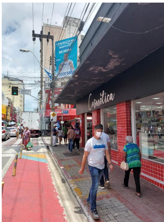
Figura 62 - Ampliação de passeio e faixa elevada na Rua Barão do Rio Branco na esquina padrão tipo I.
