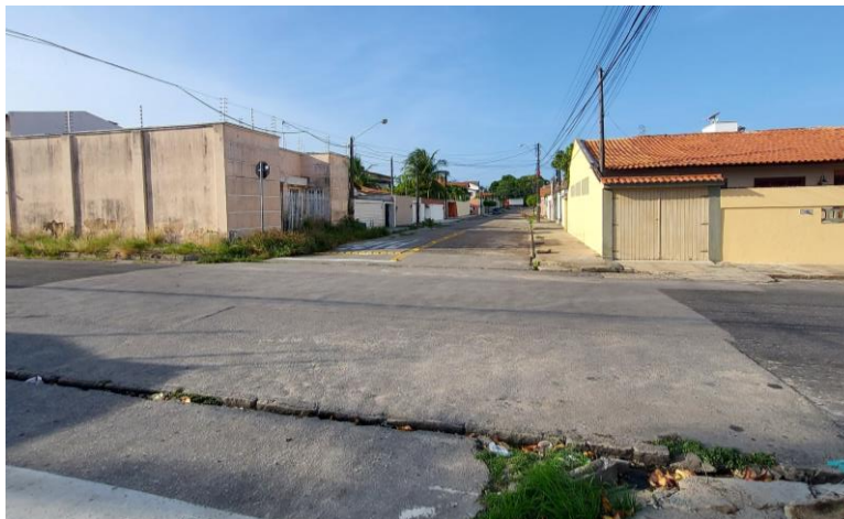
Figura 53 – Esquina padrão tipo E, em esquina de edifício abandonado.
