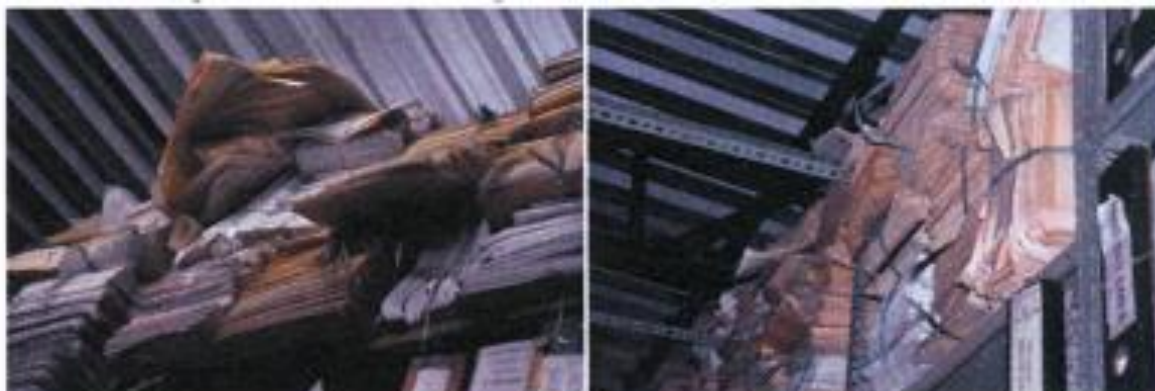
Imag. 09 e Imag. 10 - Teto metálico. Foto: Arlindo Moreira Barreto (Memorial da UFC)
