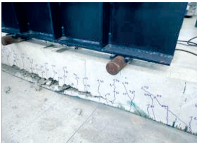
C Configuração da viga VA-3 na ruína
