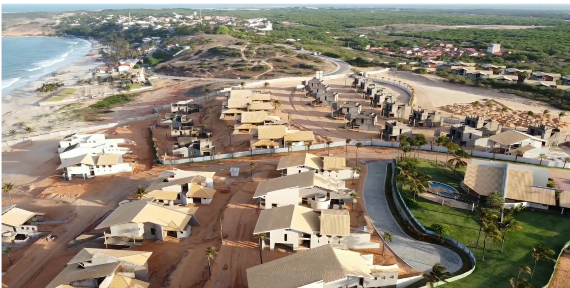
Figura 9- Andamento das obras do empreendimento do grupo Hard Rock em Lagoinha-Ce, 2020.
