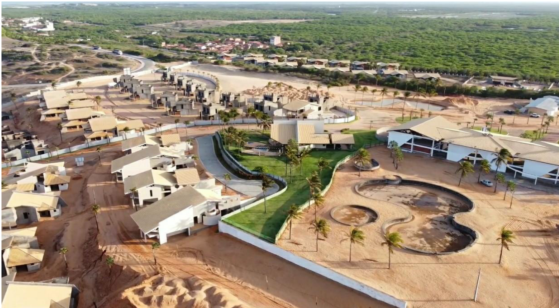
Figura 8- Andamento das obras do empreendimento do grupo Hard Rock em Lagoinha-Ce, 2020.
