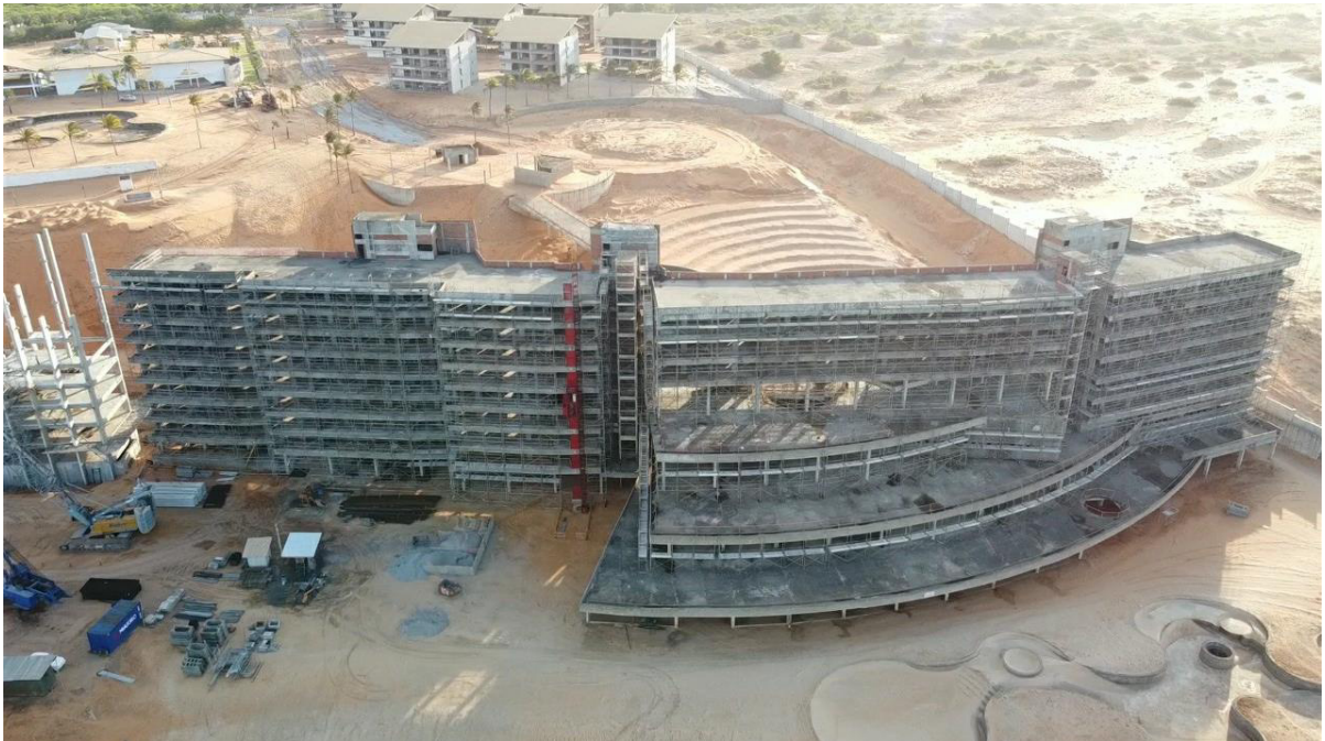
Figura 7- Andamento das obras do empreendimento do grupo Hard Rock em Lagoinha-Ce, 2020.
