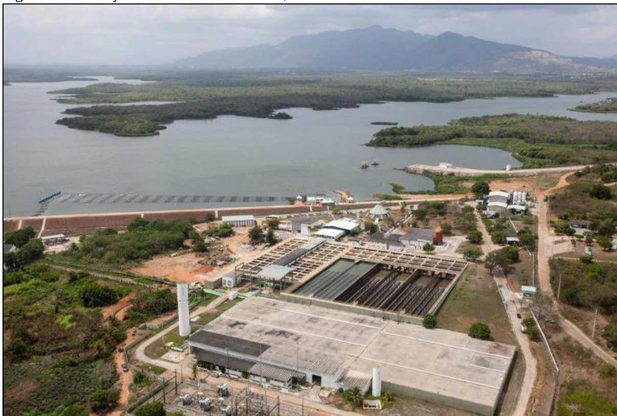
Figura 2.6 - Estação de Tratamento Gavião, no Ceará
