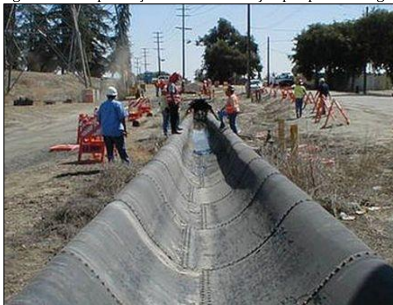
Figura 2.3 - Implantação de uma tubulação por pressão negativa
