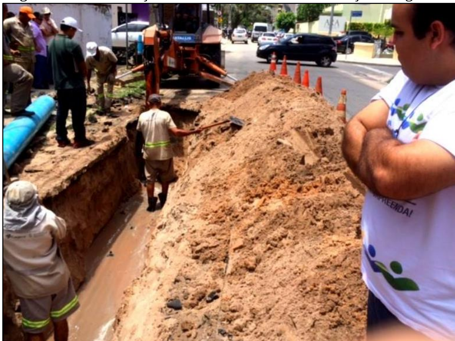
Figura 2.7 - Substituição de trecho da rede de distribuição de água
