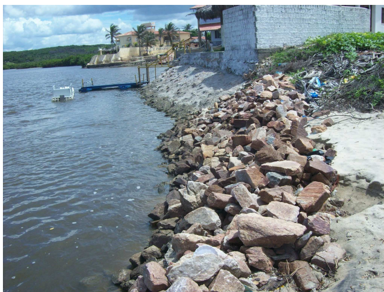
Figura 4: Pequenas obras de contenção no Malcozinhado, abril 2008 – Fonte: ROCHA
