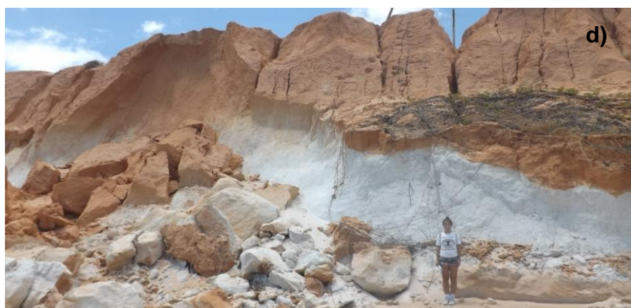
Figura 9: (a) Ravinas; b) Voçorocas; c) solapamento e d) desmoronamento nas falésias de Canoa Quebrada. Fonte: Autora.
