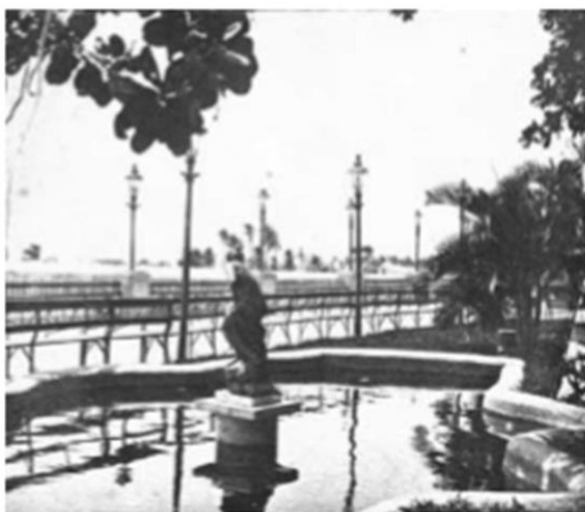
Foto 12 - Baigneuse maior (no tanque demolido) Foto Álbum, 1908
