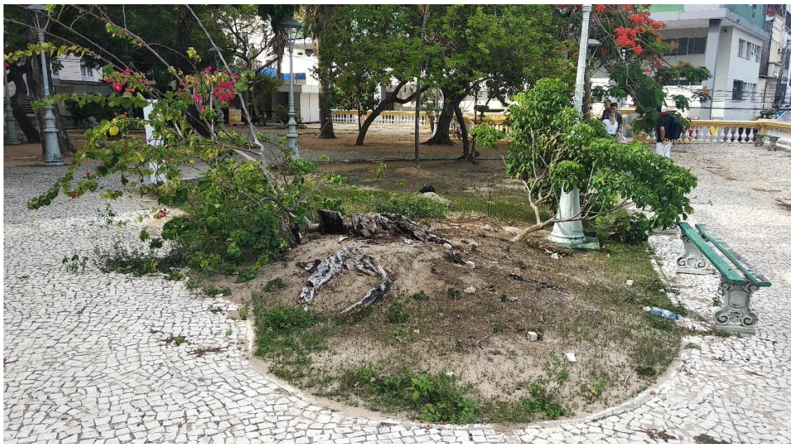
Figura 3.138.: Banco carente de pintura e reparos na Praça dos Leões. Fonte: Acervo da autora.
