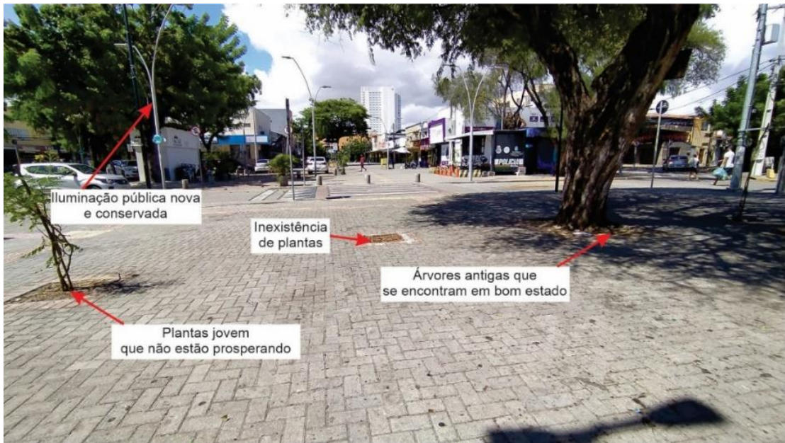
Figura3.28: Estado de conservação de piso, vegetação e iluminação. Fonte: Acervo da autora.
