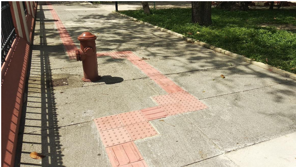
Figura 3.115.: Placas cimentícias e piso tátil na Praça dos Mártires. Fonte: Acervo da autora.
