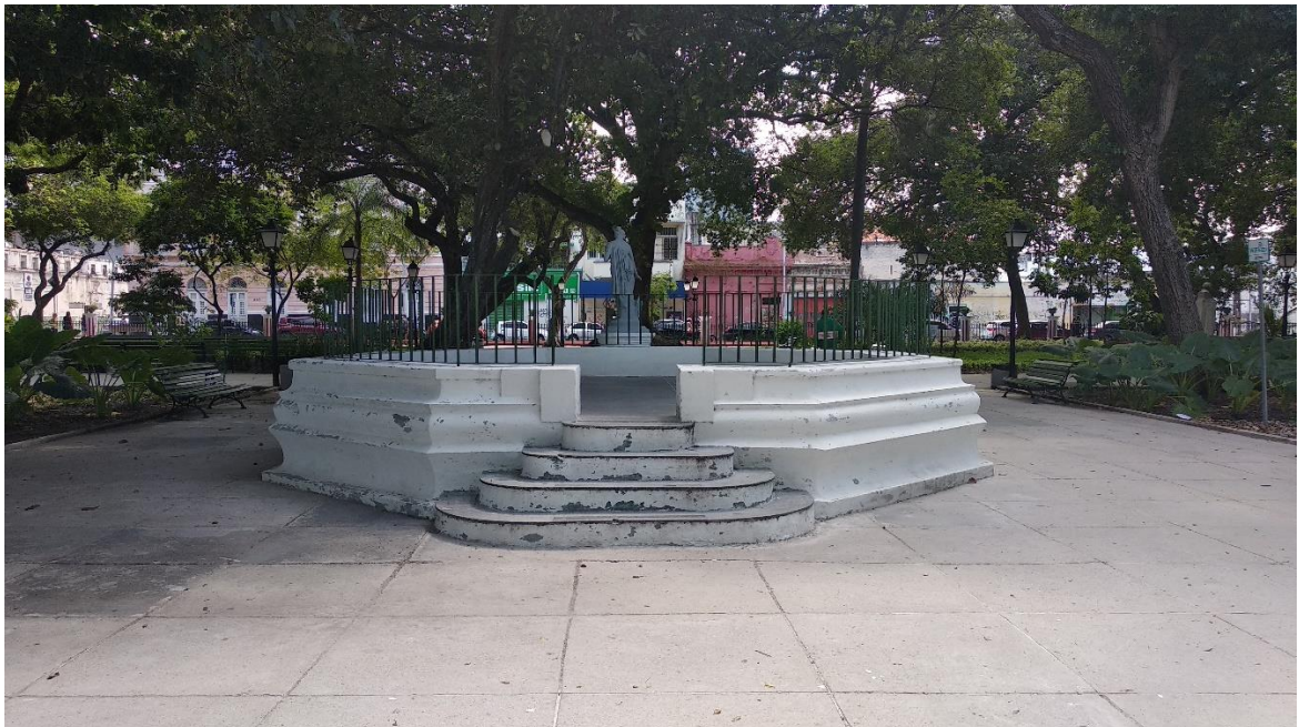
Figura 3.111: Coreto não reformado na Praça: Fonte: Acervo da autora.
