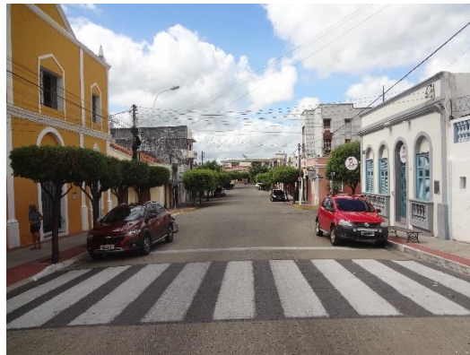
Figura 220 – Imagem atual da Figura 219. As três edificações posicionadas no cruzamento das vias se encontram em estado satisfatório de preservação, excetuando-se a antiga Capela de Santo Antônio à esquerda. Área tombada do SHS.
