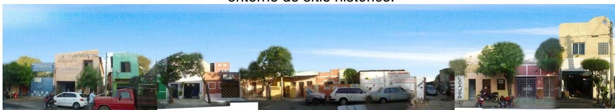
Figura 202 – Perfil de quadra 14 – edificações situadas à rua Dr. Carlito Pompeu, na área de entorno do sítio histórico.
