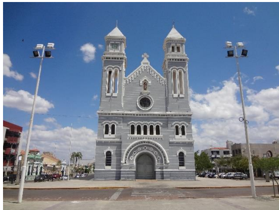
Figura 090 – Imagem atual da Figura 089. A antiga capela foi demolida e construída a atual. Área tombada do SHS.
