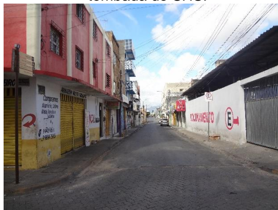
Figura 270 – Imagem atual da Figura 269. Nota-se a presença de edificações desconformes e de construção recente. Área tombada do SHS.
