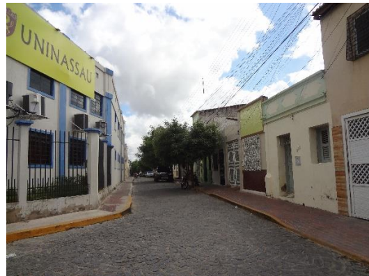
Figura 232 – Imagem atual da Figura 231. O imóvel à esquerda da rua foi erguido sobre uma edificação de construção recente que era solta no lote. Área tombada do SHS.
