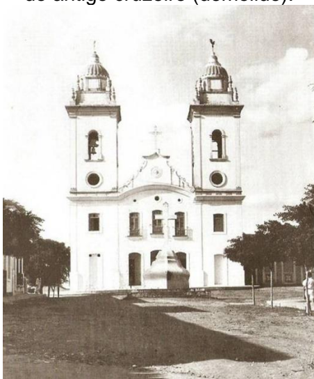
Figura 117 – Imagem da Igreja do Menino Deus na confluência da rua homônima com a rua Jornalista Deolindo Barreto, tendo a presença do antigo cruzeiro (demolido).
