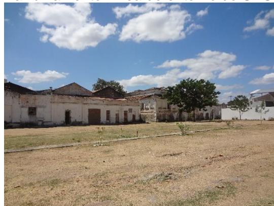
Figura 336 – Imagem atual da Figura 335. Nota-se a que grande parte das edificações da antiga Fábrica de Tecidos Ernesto Deocleciano ainda se encontra descaracterizada e em estado de arruinamento. Área de entorno do SHS.
