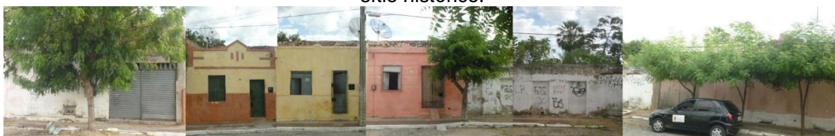
Figura 193 – Perfil de quadra 05 – edificações situadas à rua Dr. Monte, na área tombada do sítio histórico.
