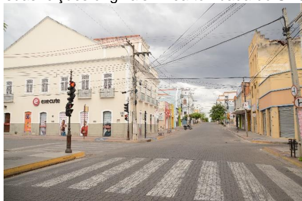
Figura 140 – Imagem atual da Figura 139. Com exceção do Sobrado Radier, quase todas as edificações deste trecho da via perderam suas feições originais. Área tombada do SHS.
