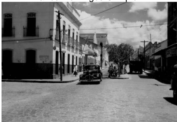
Figura 139 – Imagem da avenida Dom José. Perspectiva voltada para a confluência com a rua Domingos Olímpio.
