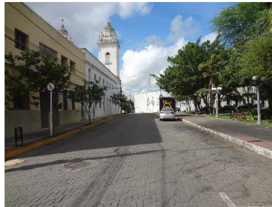
Figura 248 – Imagem atual da Figura 247. Nota-se a descaracterização da edificação disposta no ponto focal da perspectiva. Área tombada do SHS.
