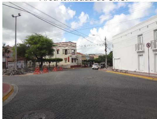
Figura 250 – Imagem atual da Figura 249. Nota-se que a edificação à esquerda se encontra completamente descaracterizada. Área tombada do SHS.
