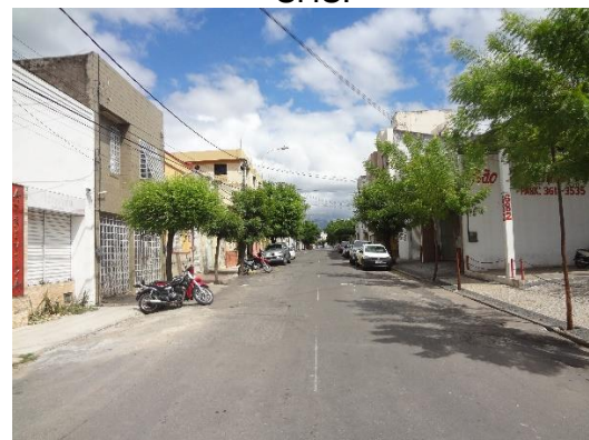
Figura 314 – Imagem atual da Figura 313. Nota-se que ambas as faces da quadra se encontram completamente descaracterizadas. Limite entre a área tombada e de entorno do SHS.
