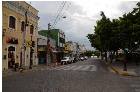
Figura 136 – Imagem atual da Figura 135. Com exceção da Academia Sobralense de Letras, percebe-se a quase total perda das feições originais do antigo casario. Área tombada do SHS.
