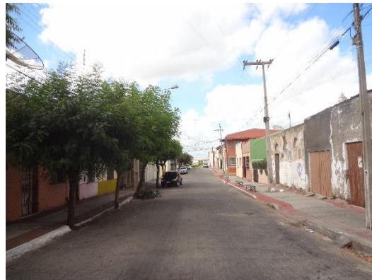
Figura 212 – Imagem atual da Figura 211. Nota-se em ambas as faces de quadra da rua a descaracterização dos imóveis. Área tombada do SHS.
