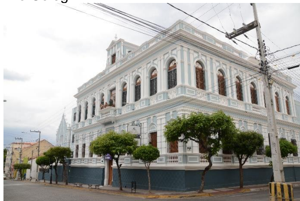
Figura 128 – Imagem atual da Figura 127. Após amplas e classicizantes reformas, a edificação serviu como residência do bispo Dom José Tupinambá da Frota e depois como o Colégio Sant’ana. Área tombada do SHS.
