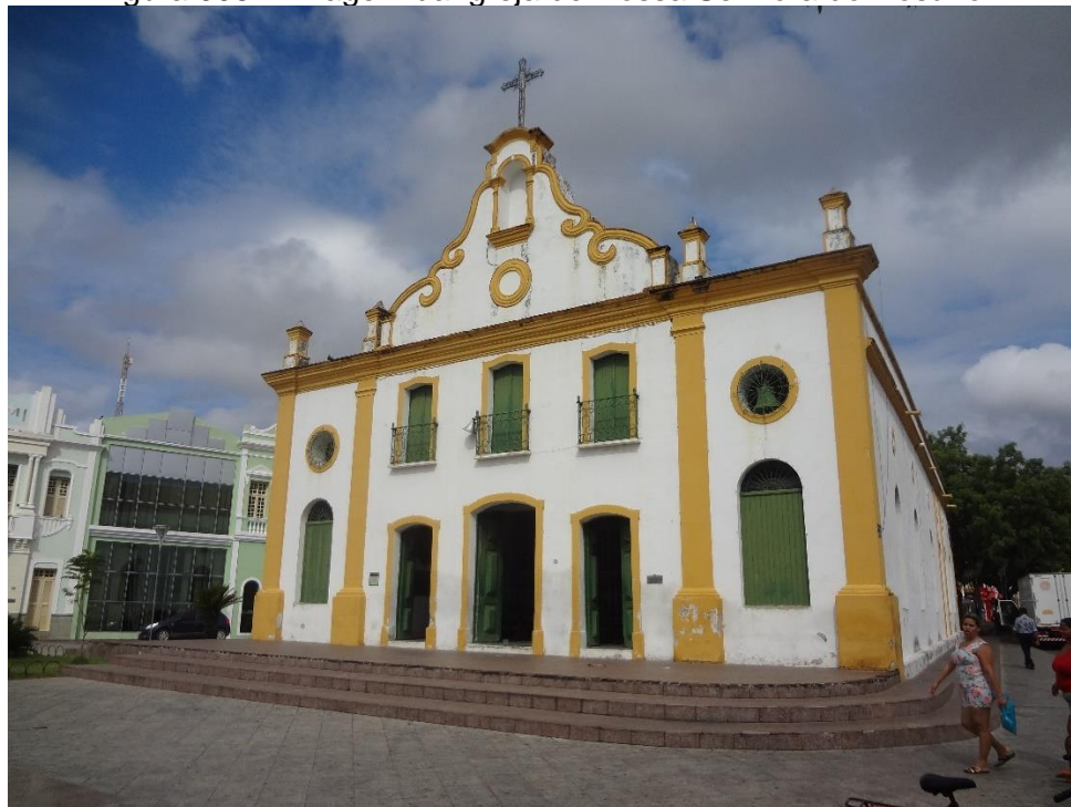
Figura 008 – Imagem da Igreja de Nossa Senhora do Rosário.
