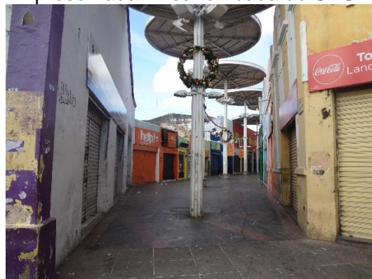
Figura 268 – Imagem atual da Figura 267. Nota-se que não há nenhuma edificação preservada. Área tombada do SHS.
