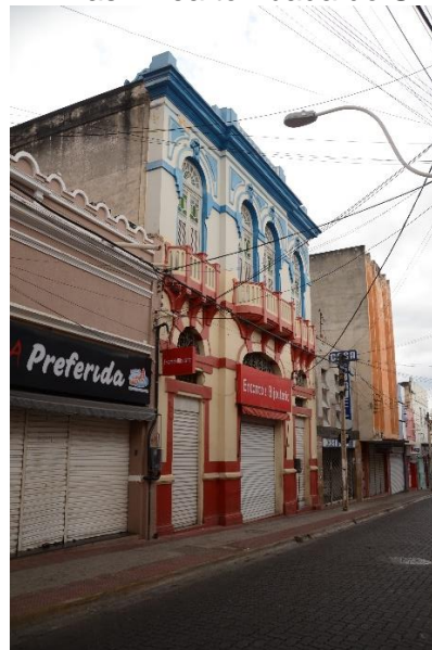
Figura 170 – Imagem atual da Figura 169. Nota-se a descaracterização das edificações vizinhas. Área tombada do SHS.
