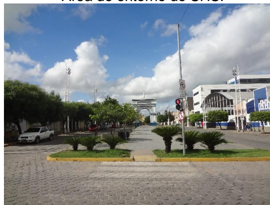
Figura 236 – Imagem atual da Figura 235. A grande diferença na perspectiva é a inserção de um amplo canteiro central na avenida. Área de entorno do SHS.
