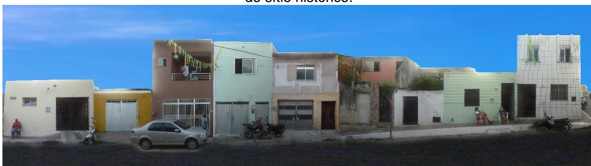
Figura 201 – Perfil de quadra 13 – edificações situadas à rua São José, na área de entorno do sítio histórico.
