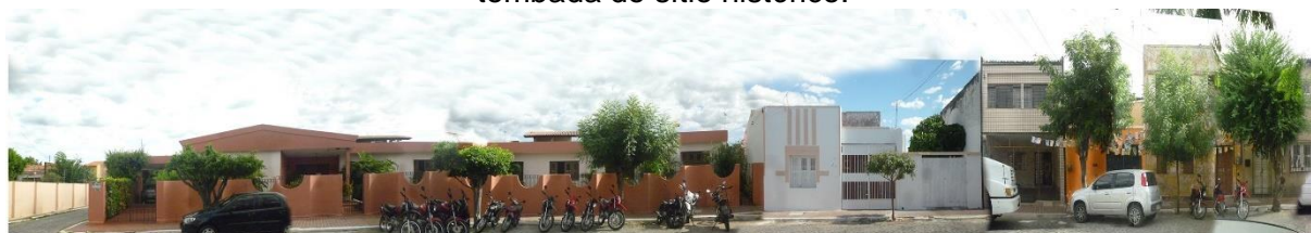
Figura 194 – Perfil de quadra 06 – edificações situadas à rua Cel. Mont'Alverne, na área tombada do sítio histórico.
