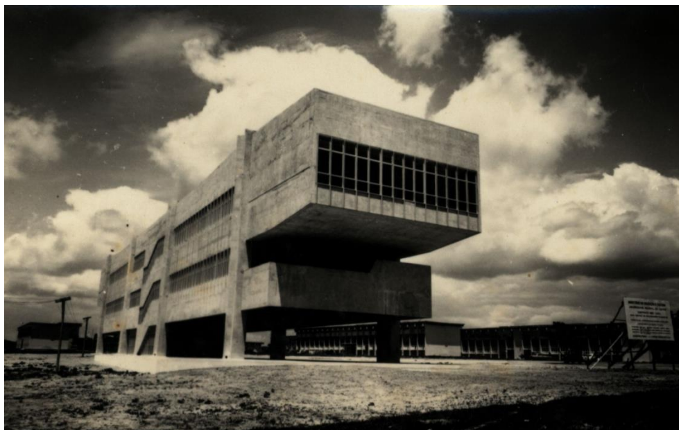
Figura 2.36 - Núcleo de Processamento de Dados UFC, Campus do Pici, 1979. Fotografia: Antônio Evangelista. Arquiteto: Nearco Araújo. Data do projeto: 1979. Fonte: acervo Memorial UFC.
