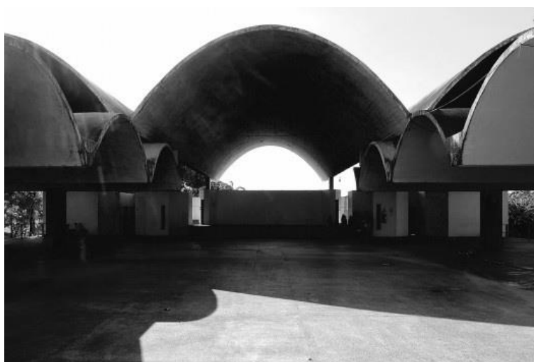
Figura 3.34 – Clube do Trabalhador e Escola de Música do Sesi. Projeto: Arquiteto Severiano Mário Porto e Engenheiro Eladio Dieste. Data do projeto: 1971. Fotografia: Ricardo Alexandre Paiva.
