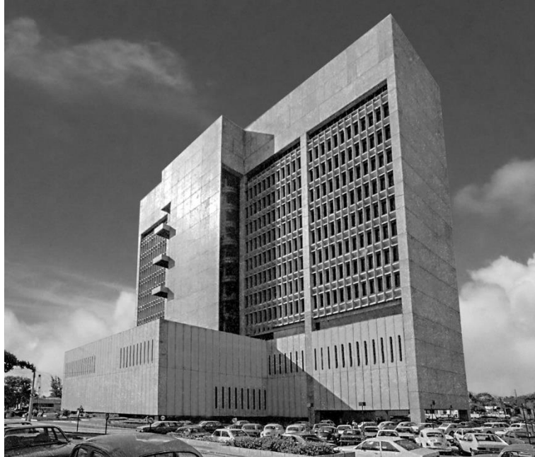
Figura 3.31 – Edifício Sede do Ministério da Fazenda. Arquiteto: Acácio Gil Borsoi. Data do projeto: 1975. Fotografia: Nelson F. Bezerra. Fonte: Arquivo Cidade Saudade - Fortaleza, décadas 1970-80.
