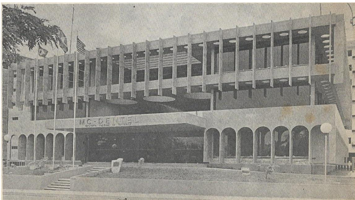
Figura 3.24 – Departamento Nacional de Telecomunicações – DENTEL. Arquitetos: Delberg Ponce de Leon e Fausto Nilo Costa Júnior. Data do projeto: 1978. Fonte: Serra e Neves; Ponce de Leon; Lima Neto, 1982.
