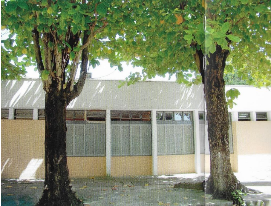
Figura 3.53 – Imprensa Universitária. Arquiteto: José Liberal de Castro. Data do projeto: 1966. Fonte: Jucá Neto; Gonçalves; Brasil, 2014.
