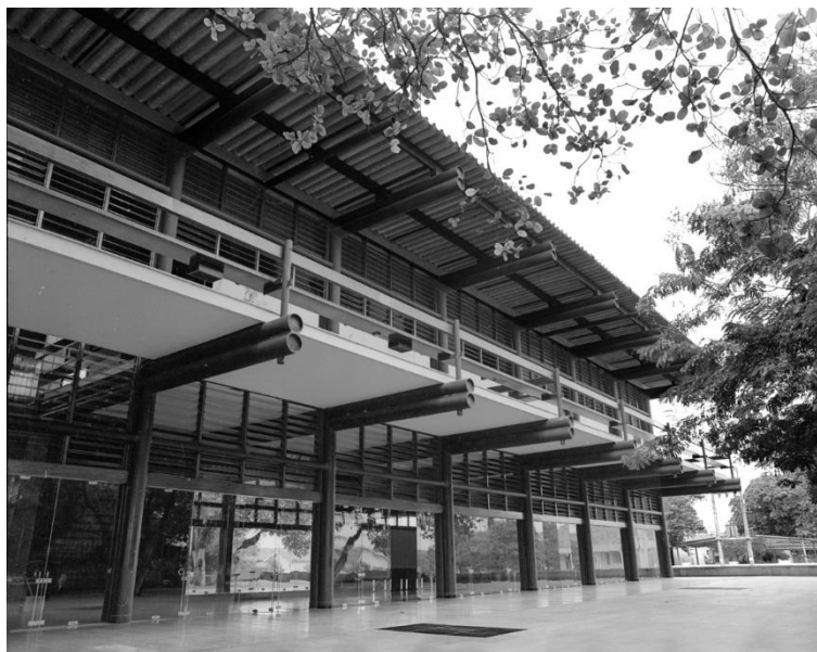
Figura 3.32 – Palácio da Abolição. Arquiteto: Sérgio Bernardes. Data do projeto: 1970. Fotografia: Nelson F. Bezerra. Fonte: Arquivo Cidade Saudade - Fortaleza, décadas 1970-80.
