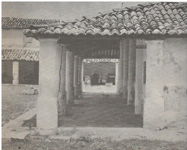
Figura 3.2 – Mercado da Carne, Aquiraz. Fonte: Serra e Neves; Ponce de Leon; Lima Neto, 1982.
