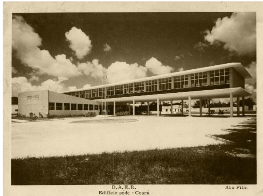
Figura 2.32 - Edifício sede do DAER - Departamento Autônomo de Estradas e Rodagem (atual Procuradoria Geral de Justiça do Ministério Público) - s/d Fotografia: autor desconhecido. Arquiteto: José Armando Farias. Data do projeto: 1961. Fonte: acervo da família Armando Farias.
