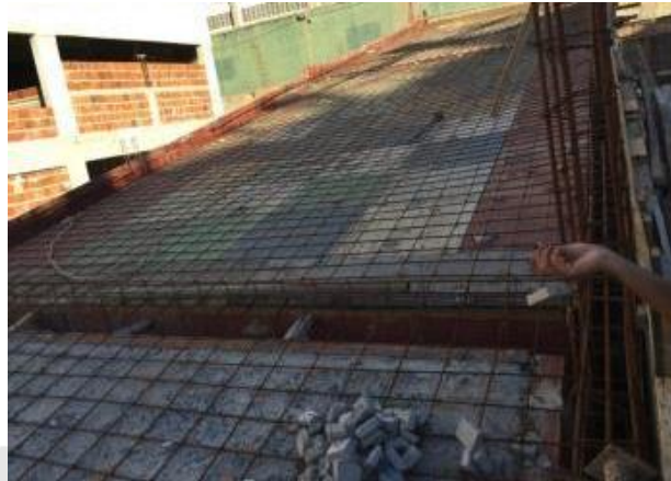
Figura 2 – Rampa de acesso com utilização de plasterit .
