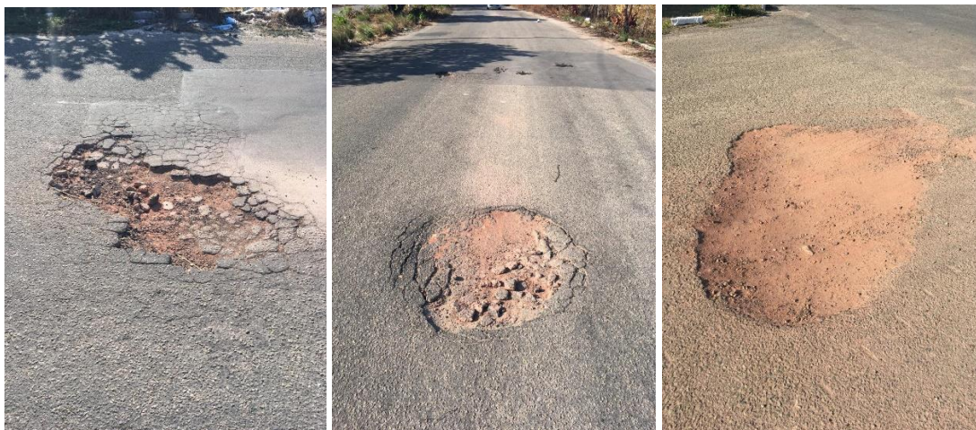
Figura 18 — Exemplos de painelas encontradas na região de estudo.
