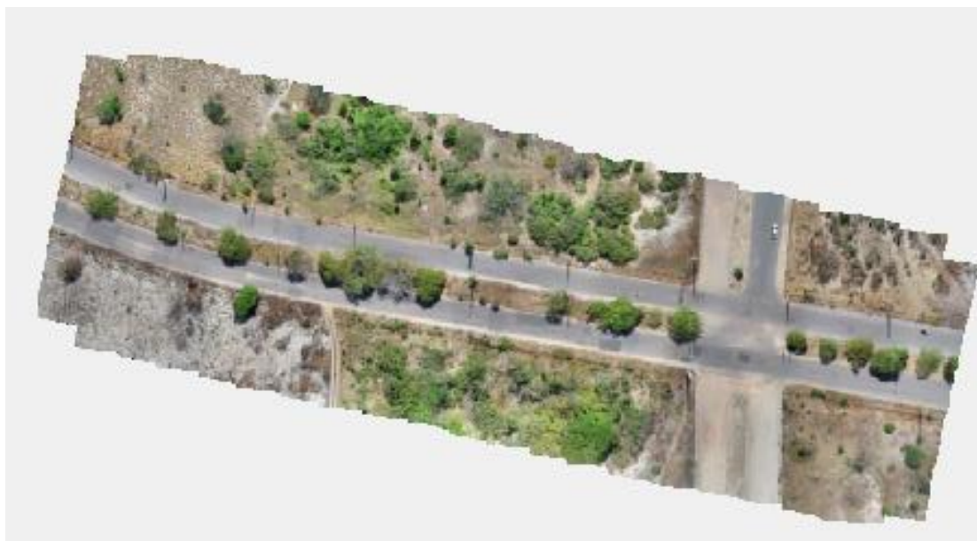
Figura 24 — Ortomosaico gerado após processamento.
