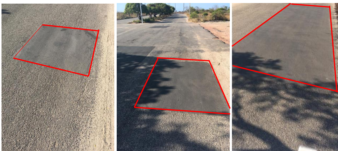
Figura 19 — Exemplos de remendos encontrados na região de estudo.
