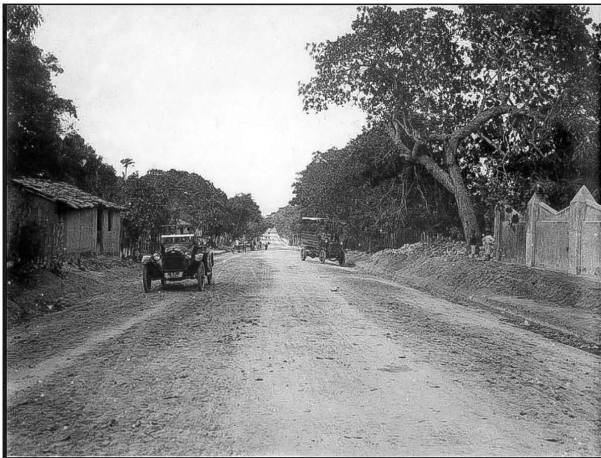
Figura 5 - Estrada que conecta Fortaleza e Poranga, em 1919
