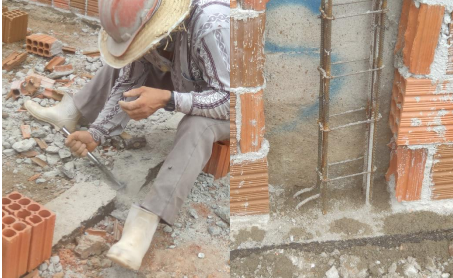
Figura 20 - Pedreiro corrigindo erro deixado pela equipe de fundação.
