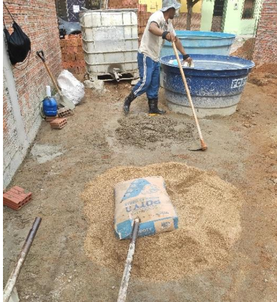
Figura 12 – Local de produção de argamassa, obra A.
