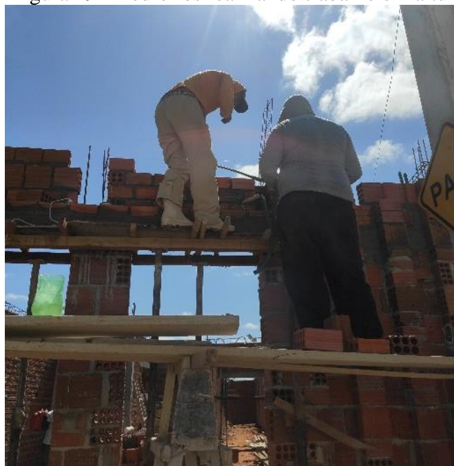
Figura 19 – Pedreiros realizando trabalho em altura.
