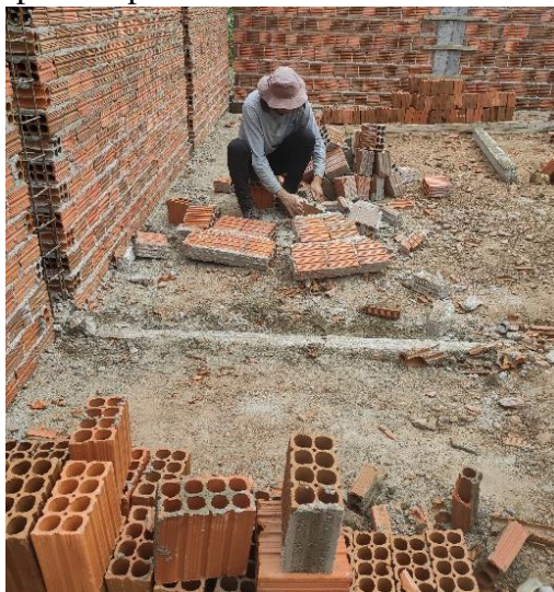
Figura 17 – Funcionário desmembrando blocos cerâmicos de parede demolida, para reaproveitamento.
