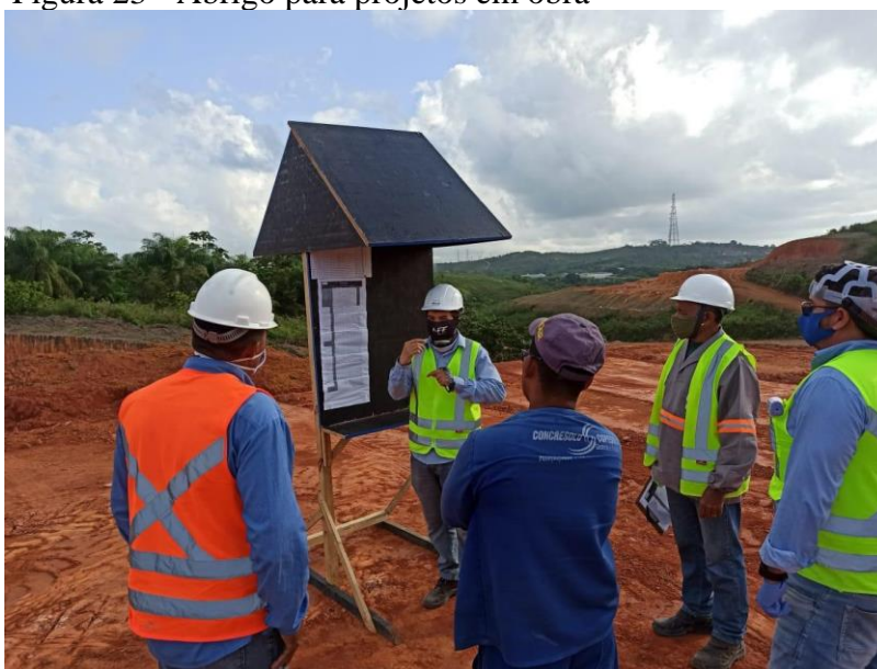
Figura 23 - Abrigo para projetos em obra
