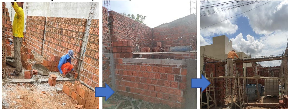
Figura 8 – Etapas de execução do serviço de alvenaria de bloco cerâmico.
