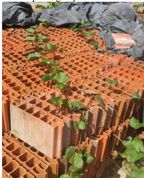
Figura 11 – Lajotas cerâmicas em obra coberta por vegetação
