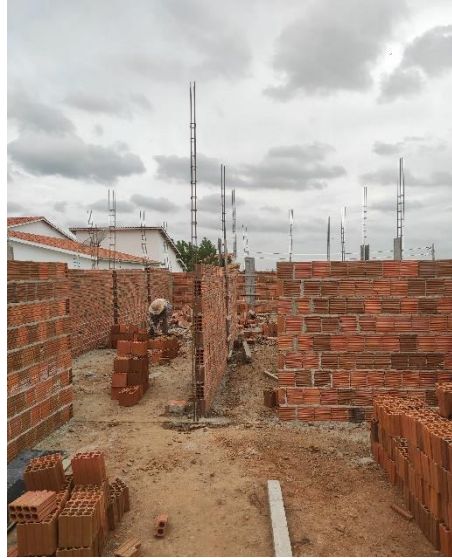
Figura 5 – Vista interna obra B
