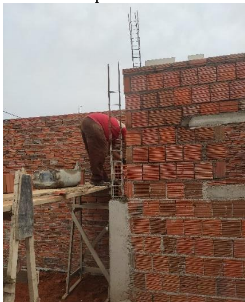
Figura 9 – Pedreiro utilizando andaime de madeira improvisado
