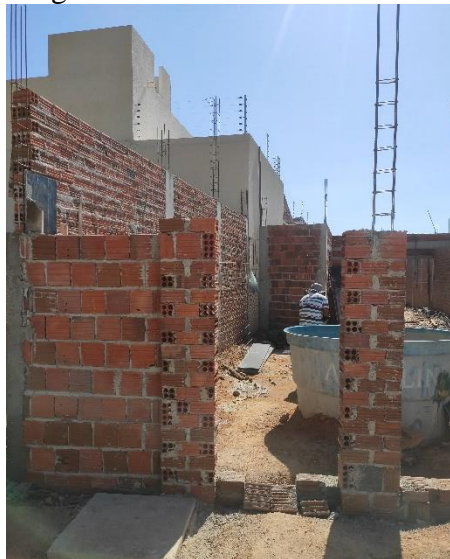
Figura 4 - Vista frontal obra A
