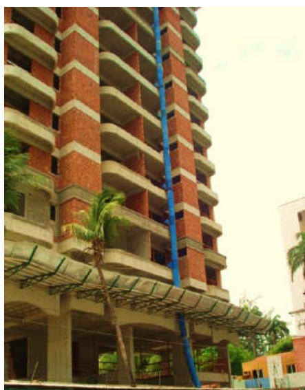
Figura 1 - Tubulação para transporte de entulho por gravidade
