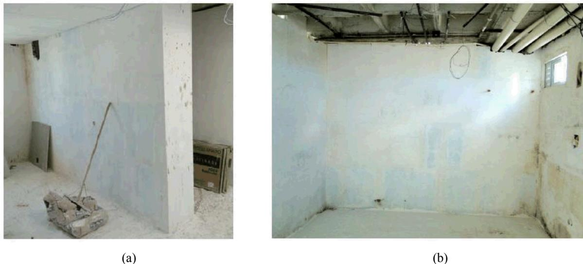
Figura 4.1 – Blocos de gesso utilizados para divisórias. (a) Divisória que separa o quarto de um banheiro. (b) Blocos de gesso da cozinha.
