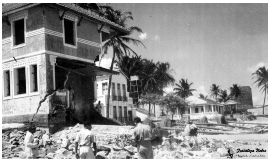
Figura 15 - Bangalô destruído em decorrência do avanço do mar.
