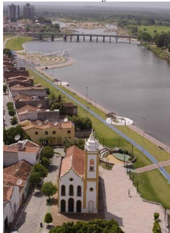
Figura 5 - Margem Esquerda do Rio Acaraú onde se vê no plano principal o rio e a Igreja de Nossa Senhora das Dores a mais antiga de Sobral
