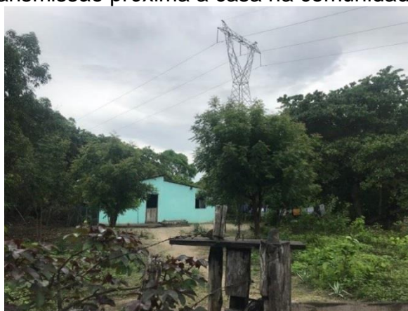
Figura 51 - Linha de transmissão próxima a casa na comunidade de Ziú, Camocim-CE.
