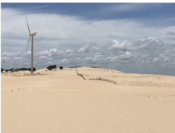
Figura 26 - Cerca de longo comprimento sobre o campo de dunas móveis.
