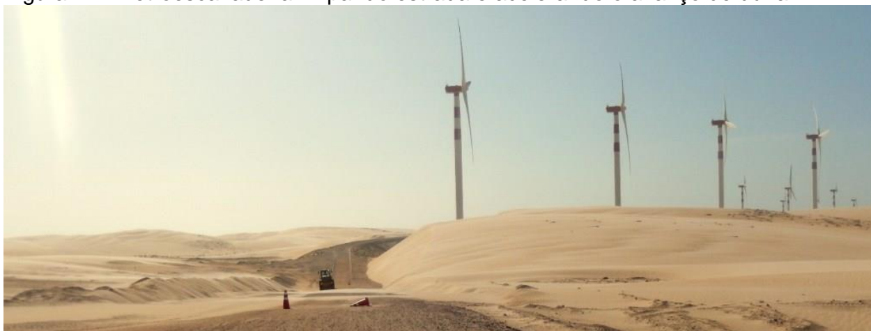
Figura 42 - Retroescavadeira limpando estrada e acelerando o avanço de duna.
