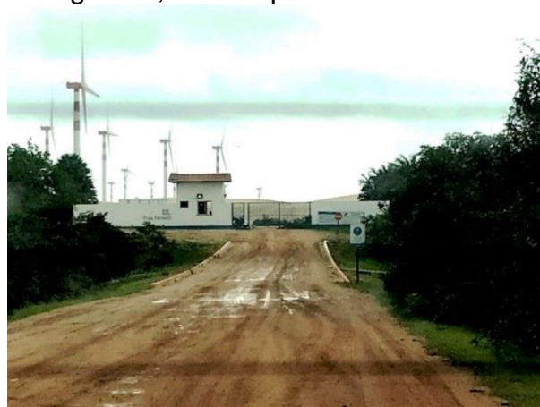
Figura 55 - Entrada reformada do parque com guarita, muro e portão.
