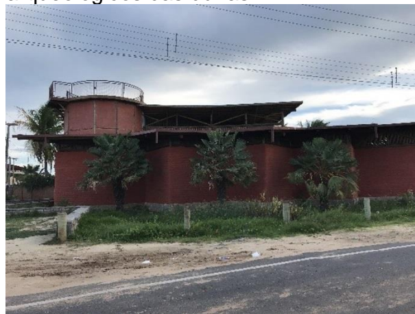
Figura 25 - Prédio construído para ser o museu para as peças resgatadas dos sítios arqueológicos das dunas.
