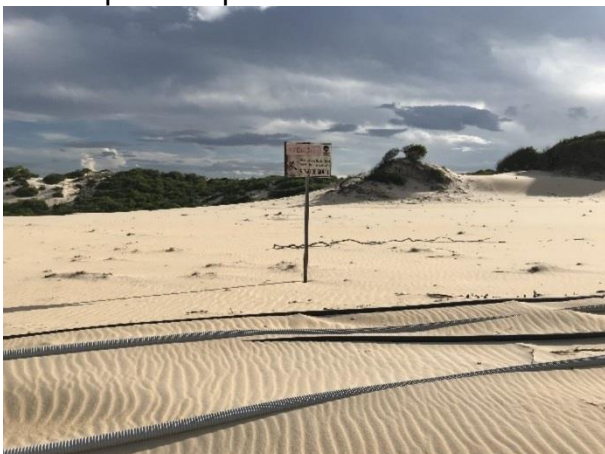
Figura 33 - Placa alertando o “risco de morte” por choque elétrico.
