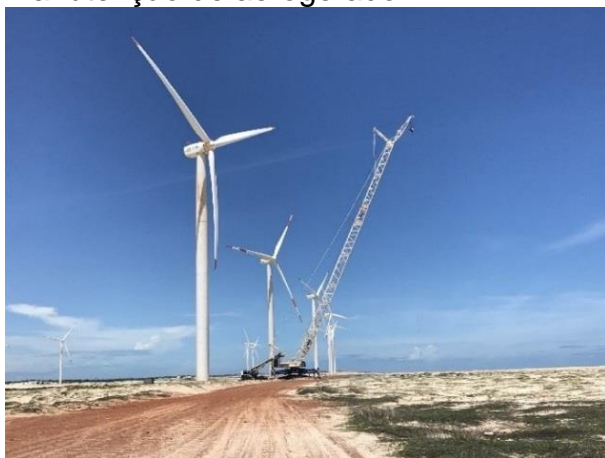
Figura 37 - Guindaste realizando manutenção de aerogerador.
