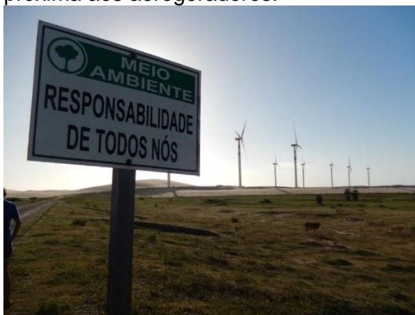
Figura 62 - Placa de “educação ambiental” próxima aos aerogeradores.
