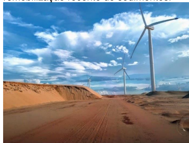
Figura 20 - Duna avançando sobre estrada do parque eólico e corte indicando remobilização recente de sedimentos.
