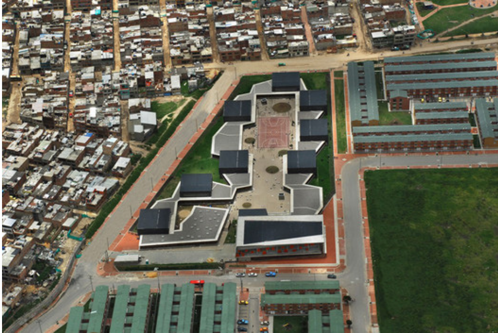
Figura 20. Vista aérea Gerardo Molina. Fonte: https://www.archdaily.com/8660/gerardo-molina-school-giancarlo-mazzanti .
