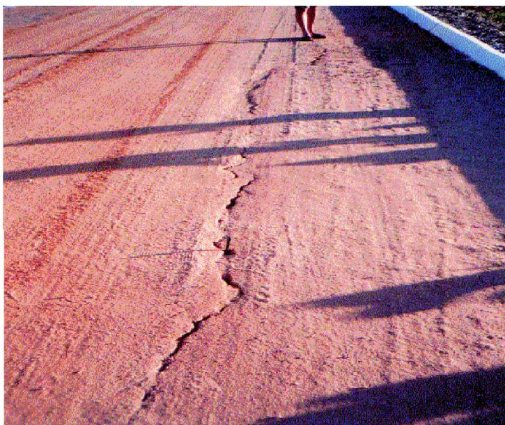
**FOTO 1 -** Trincas longitudinais no coroamento da Barragem Trussu (abril/1997).
