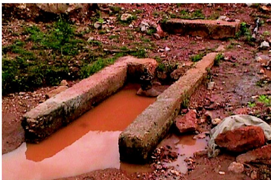
**FOTO 2:** Tomada d'água do Açude Martinópolis antes das obras de recuperação.
