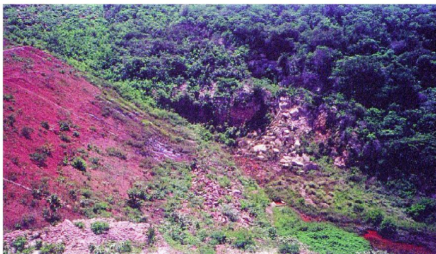
**FOTO 4:** Vista geral da surgência no talude de jusante, da cratera na ombreira esquerda do vale principal e dos dois medidores de vazão junto ao pé da barragem.
