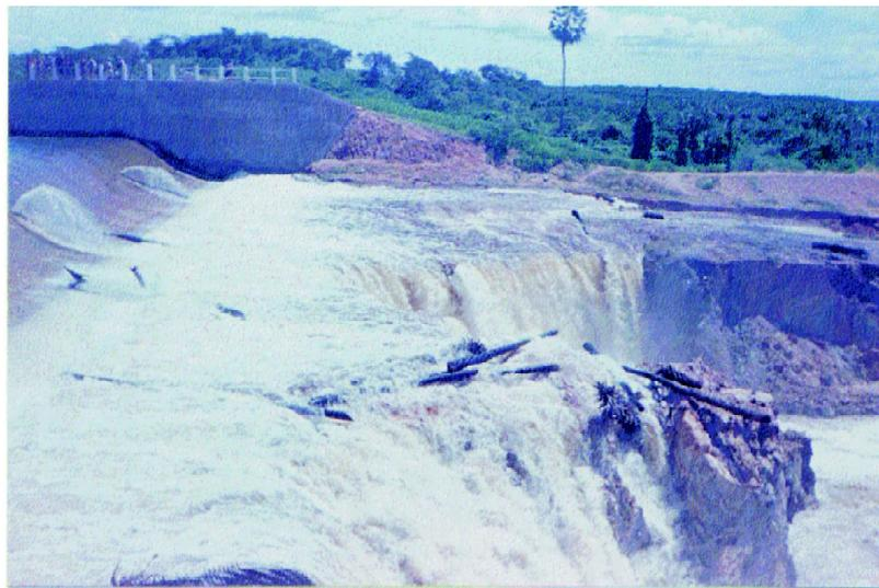
**FOTO 3** - Erosão regressiva no sangradouro da Barragem Itaúna (abril/2001).
